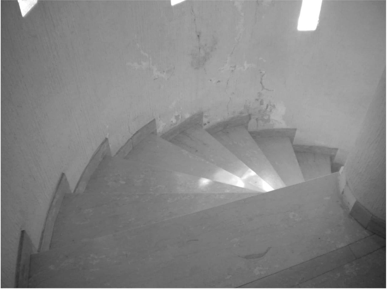
scala interna accesso pianerottolo
