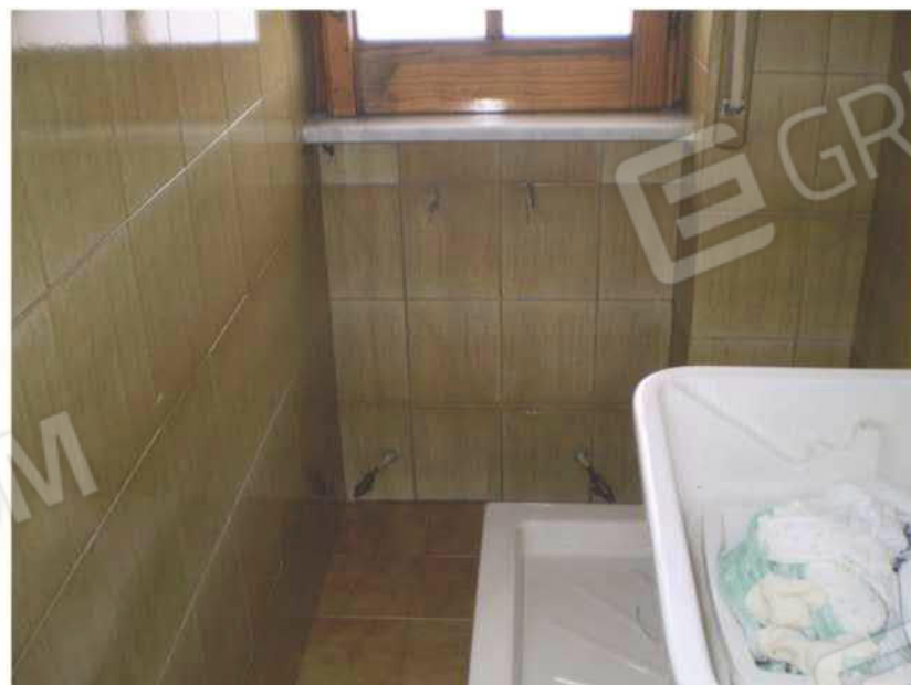
Foto n. 6– Vista interna - Bagno di servizio
