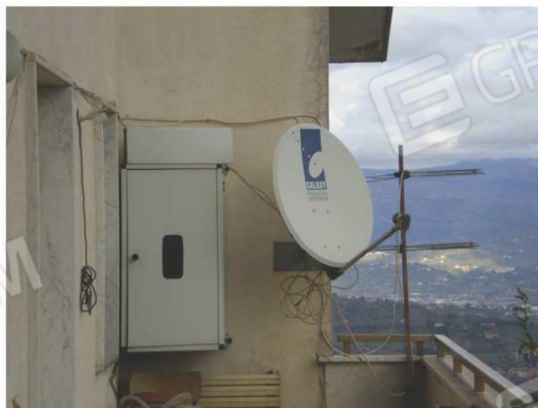
Foto n. 12 – Caldaia esterna (non funzionante) su balcone laterale
