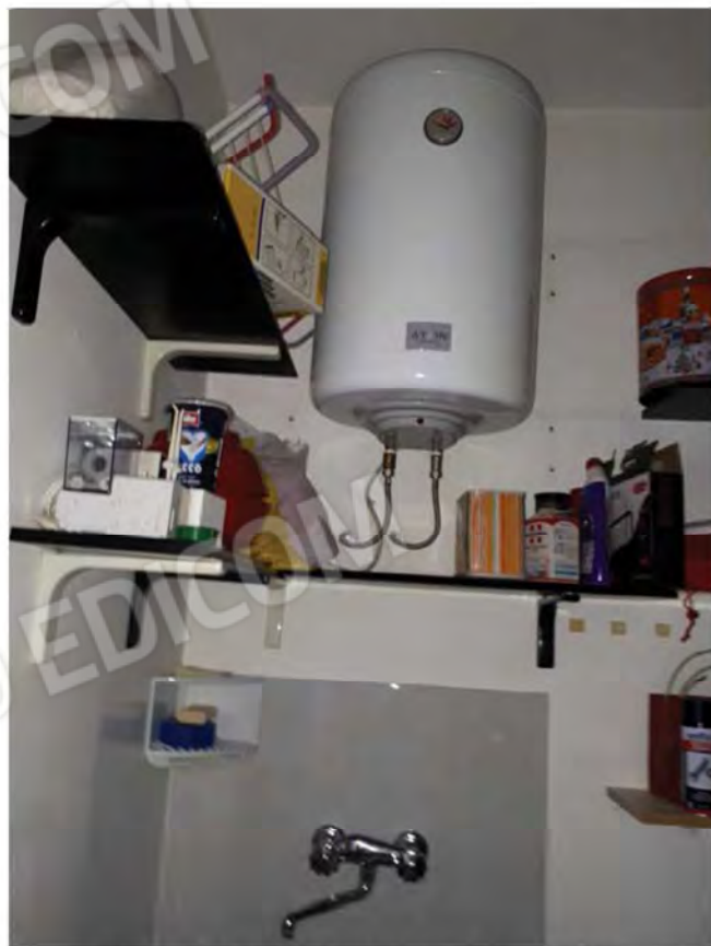
FOTO 24. APPARTAMENTO B – RIPOSTIGLIO
