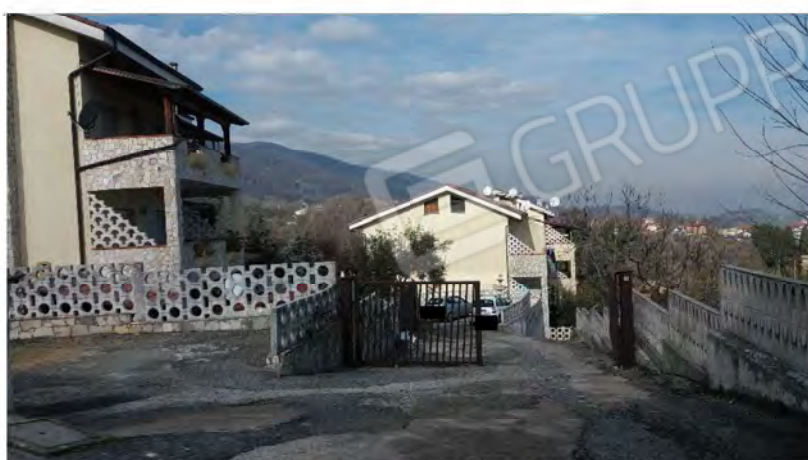
Foto 2: Ingresso al complesso immobiliare da Via Fontanelle
