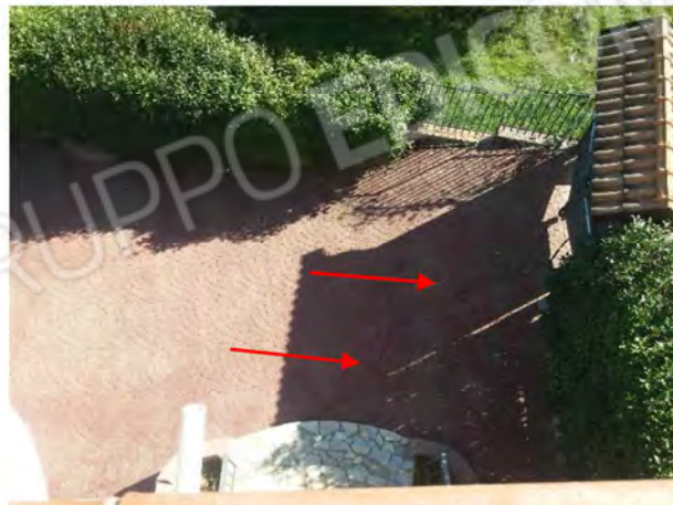
Foto 11 e 12: Ingresso corte privata. Con le frecce si evidenziano le lesioni alla pavimentazione
