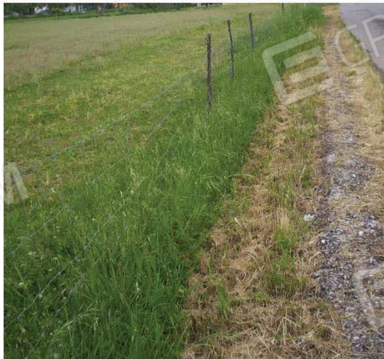
Vista particolare recinzione Lotto 1
