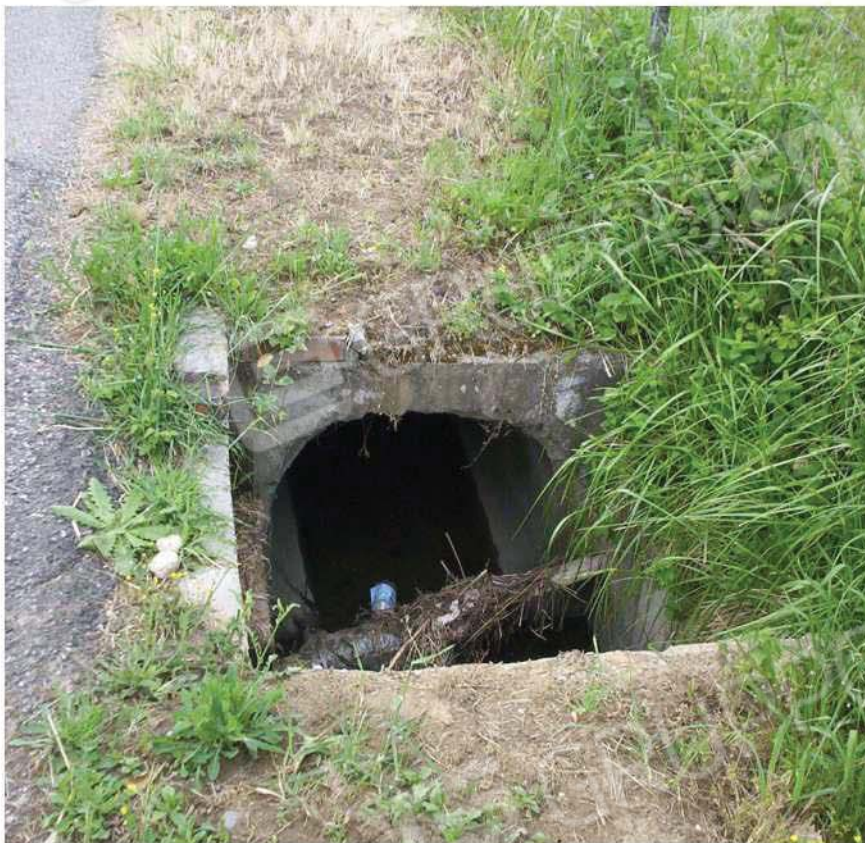
Vista particolare pozzetto canale irriguo lato strada Lotto 1
