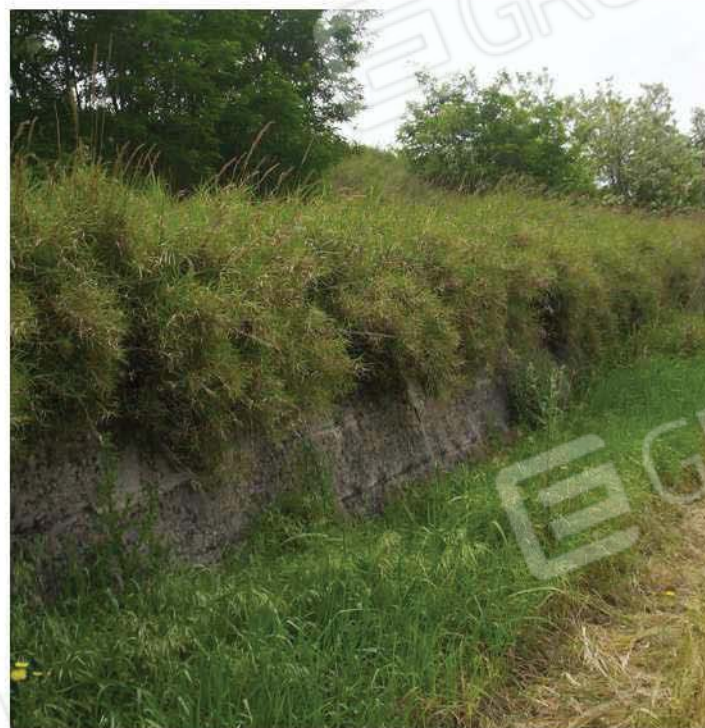
Vista particolare muro sostegno rilevato ferroviario lato strada interpodereale
