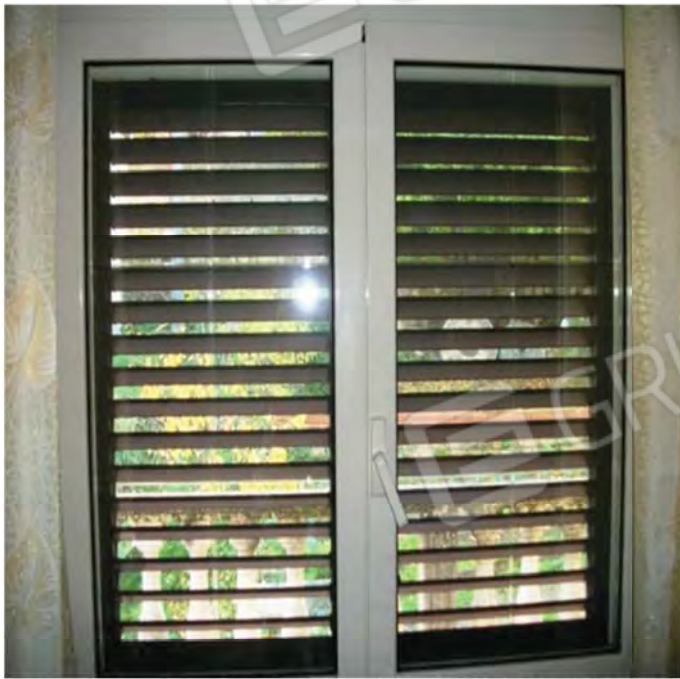
Foto n. 33 , 34 - Particolare tipo degli infissi interni delle finestre in alluminio semplice adottate al P.T.M. del Fabbricato.
