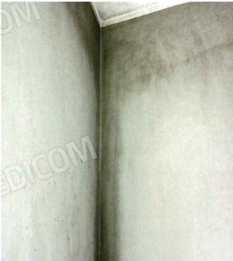
Foto n. 38, 39 , 40, 41 - Particolare parete e soffitto al P.T.M. del Fabbricato, dove si evidenzia presenza di umidità e di muffa, dovuta sicuramente ad un carente isolamento tra l'esterno e l'interno.
