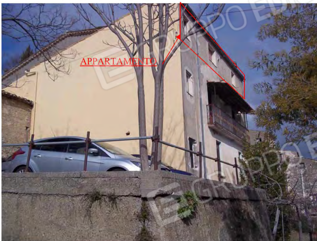
FOTO N° 3 – Appartamento oggetto dell'esecuzione (Piano Secondo)
