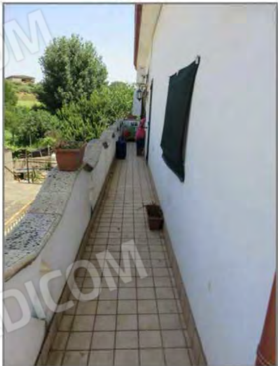
Balcone lato nord
