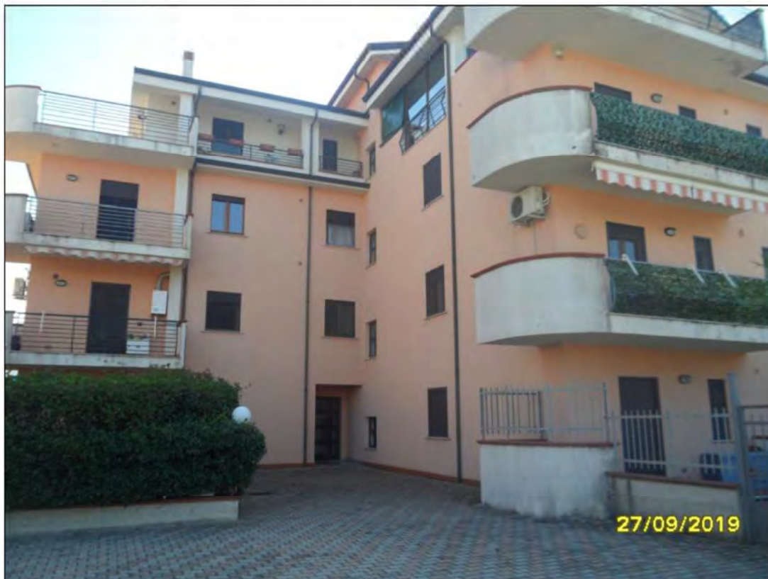
Figura n.3: Corte interna dello stabile e vista della scala condominiale di accesso all'immobile oggetto di pignoramento.
