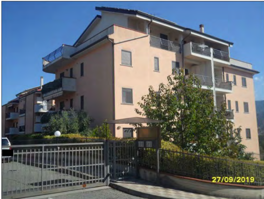
Figura n.2: Cannello pedonale e carrabile di ingresso al Complesso Immobiliare "Casanova".
