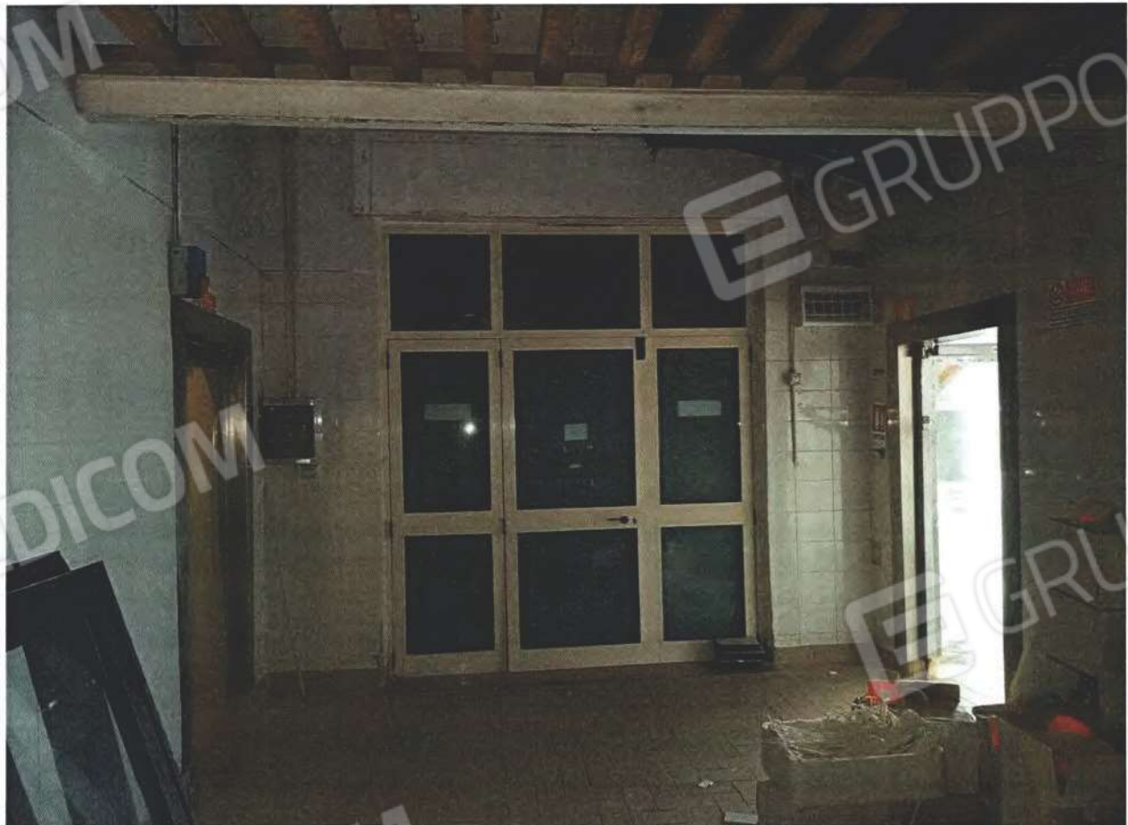
VISTA INTERNA LATO OVEST PRIMA STANZA DEL SUB. 2
