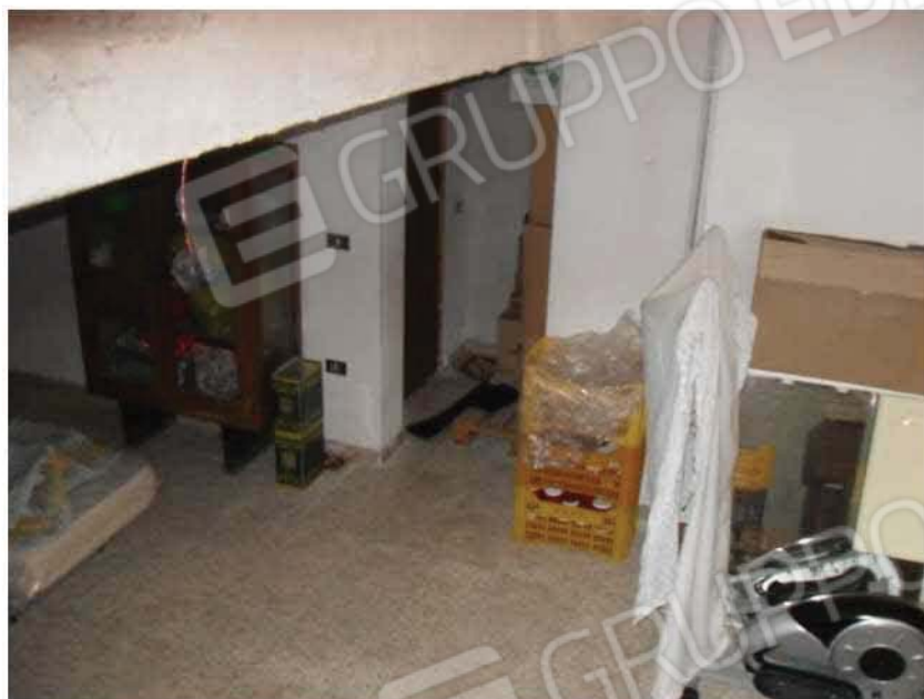
Foto N.31: Vista bagni del sub 10
