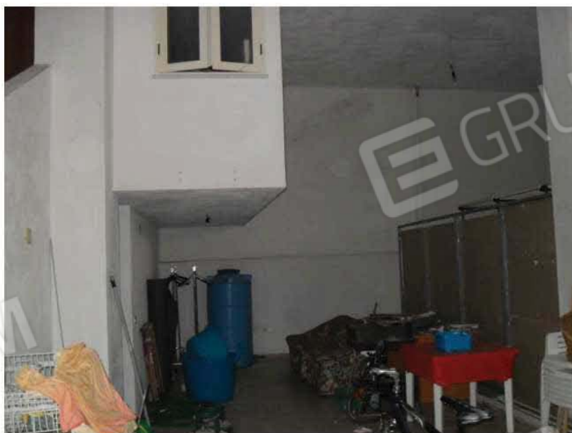
Foto n. 20: Parte Sx magazzino sub 9
