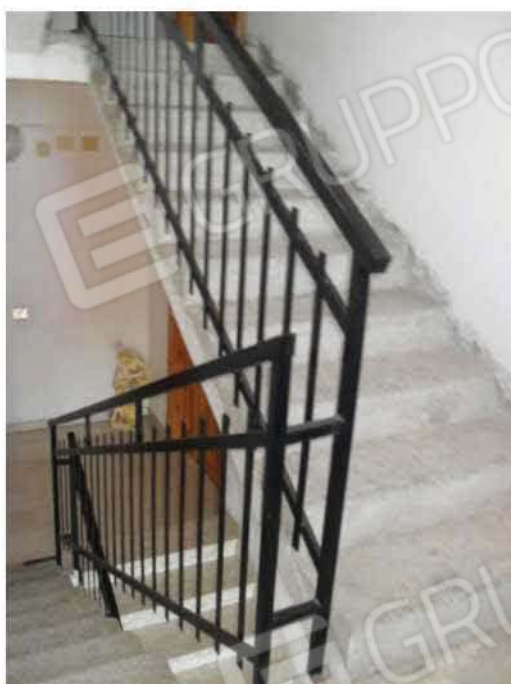
Foto N. 33: Ingresso appart. P.1° sub 3, scala e sub 5
