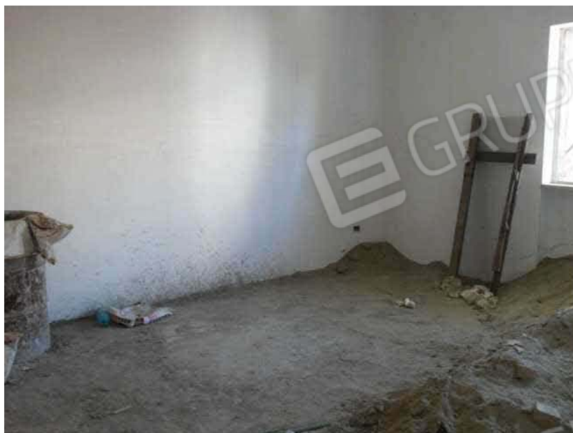
Foto N. 43: Interno camera a Sx
