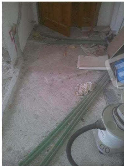
Foto N. 39: Ingresso appart. 2° P. Sub 5
