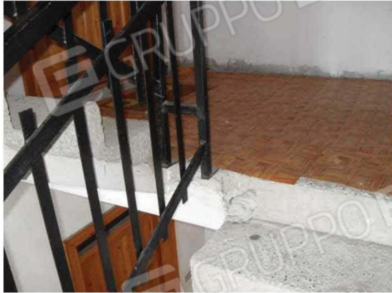
Foto N. 38: Pianerottolo 2° P ed ingresso appart. Sub 6
