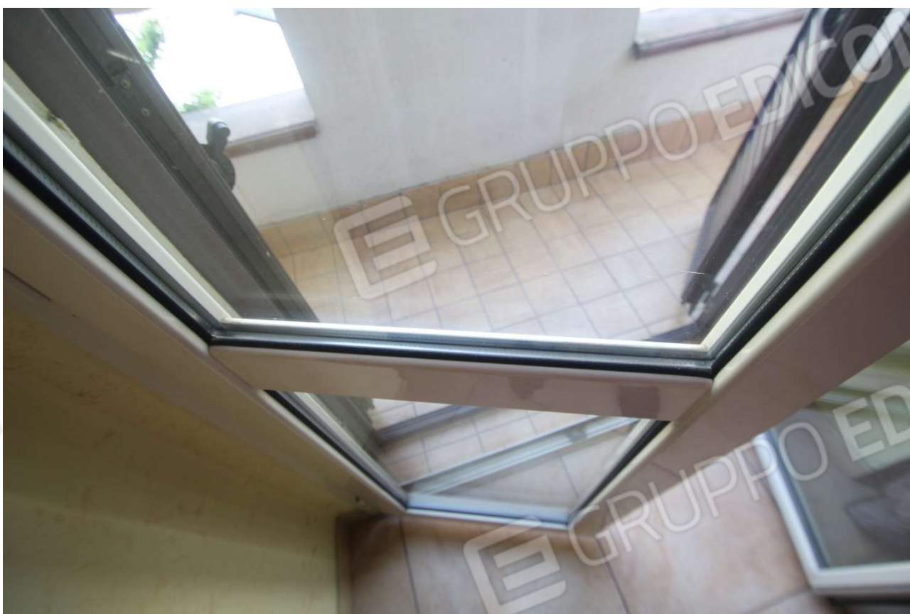
Particolare: infisso interno
