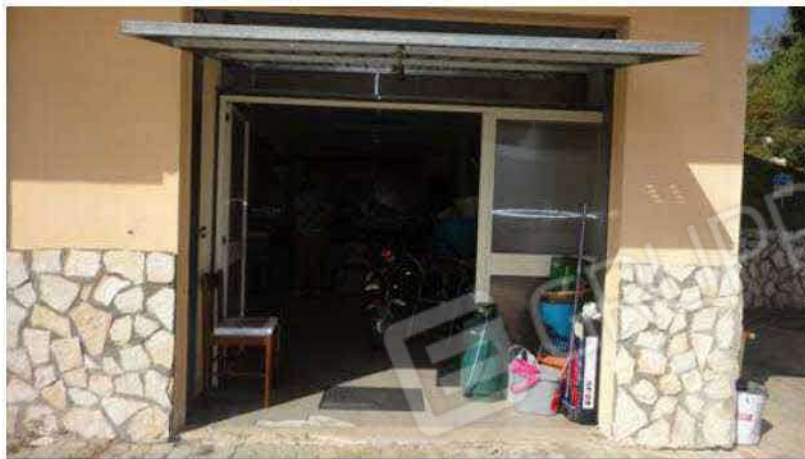
Figura 8 Ingresso garages dal prospetto frontale
