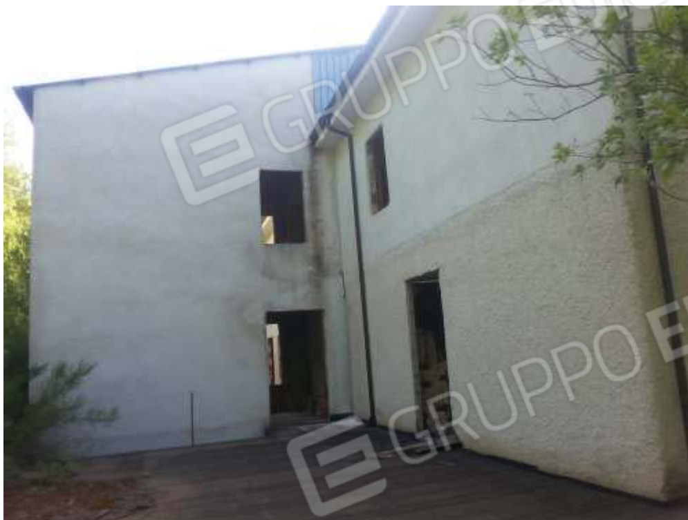
FOTO N° 30 (terrazzo piano primo)
