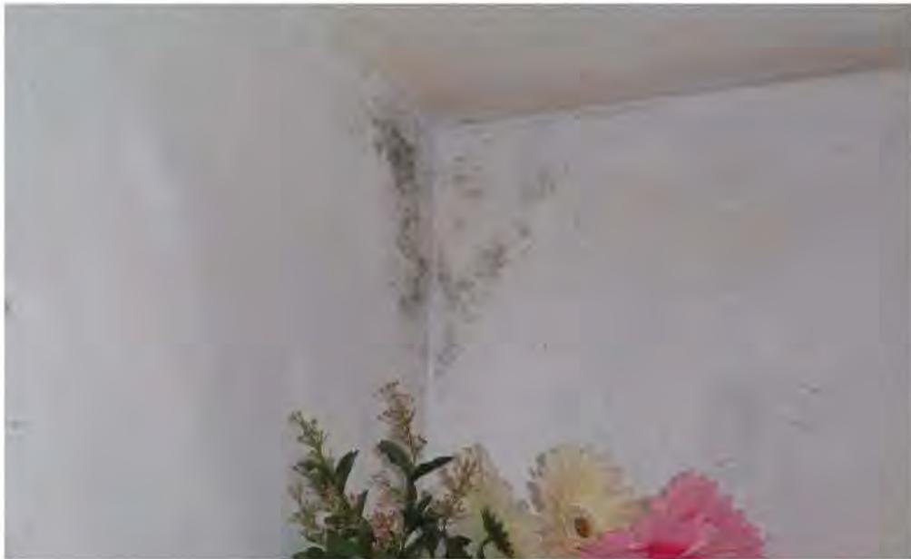
*Figura 13 – Evidenti macchie di umidità*
