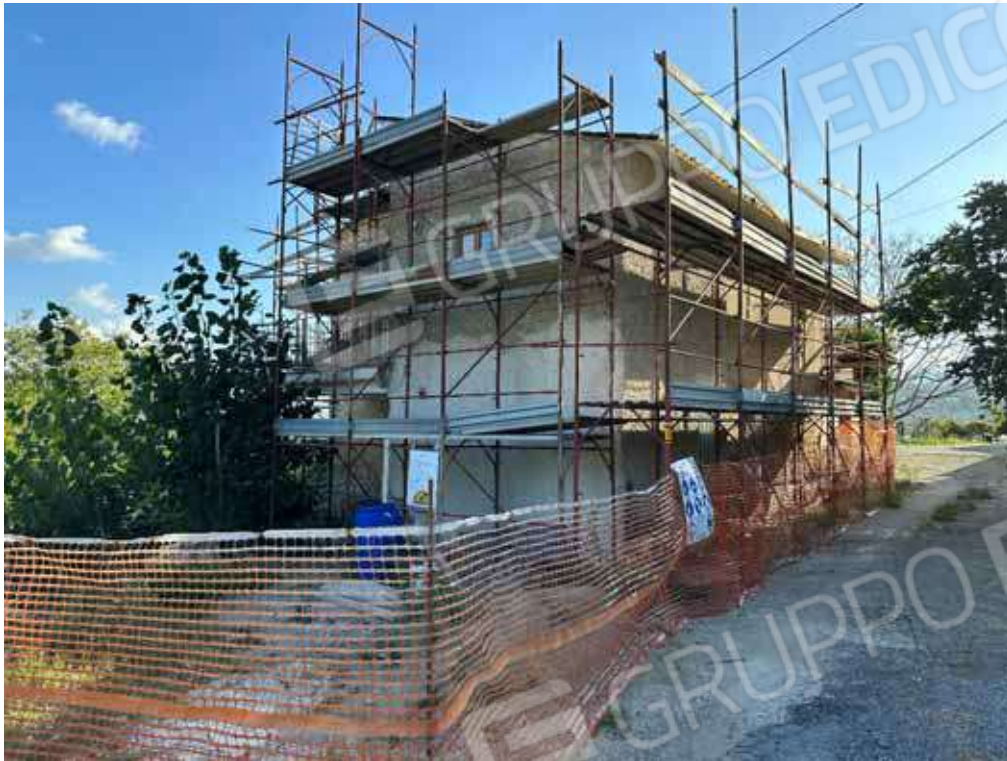
Foto 1: Unità immobiliare Fg. 4 P.IIa 433 sub 1.
