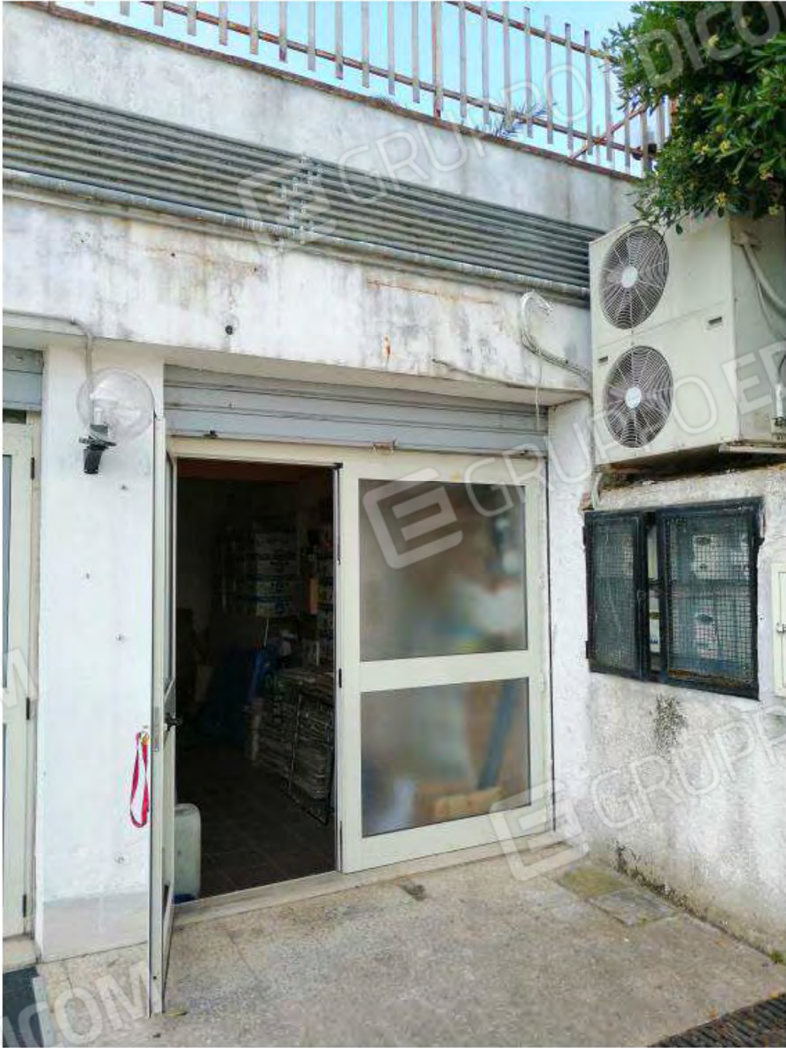
Foto 4 - Vista esterna Ingresso Intercapedine (Sub. 1)
