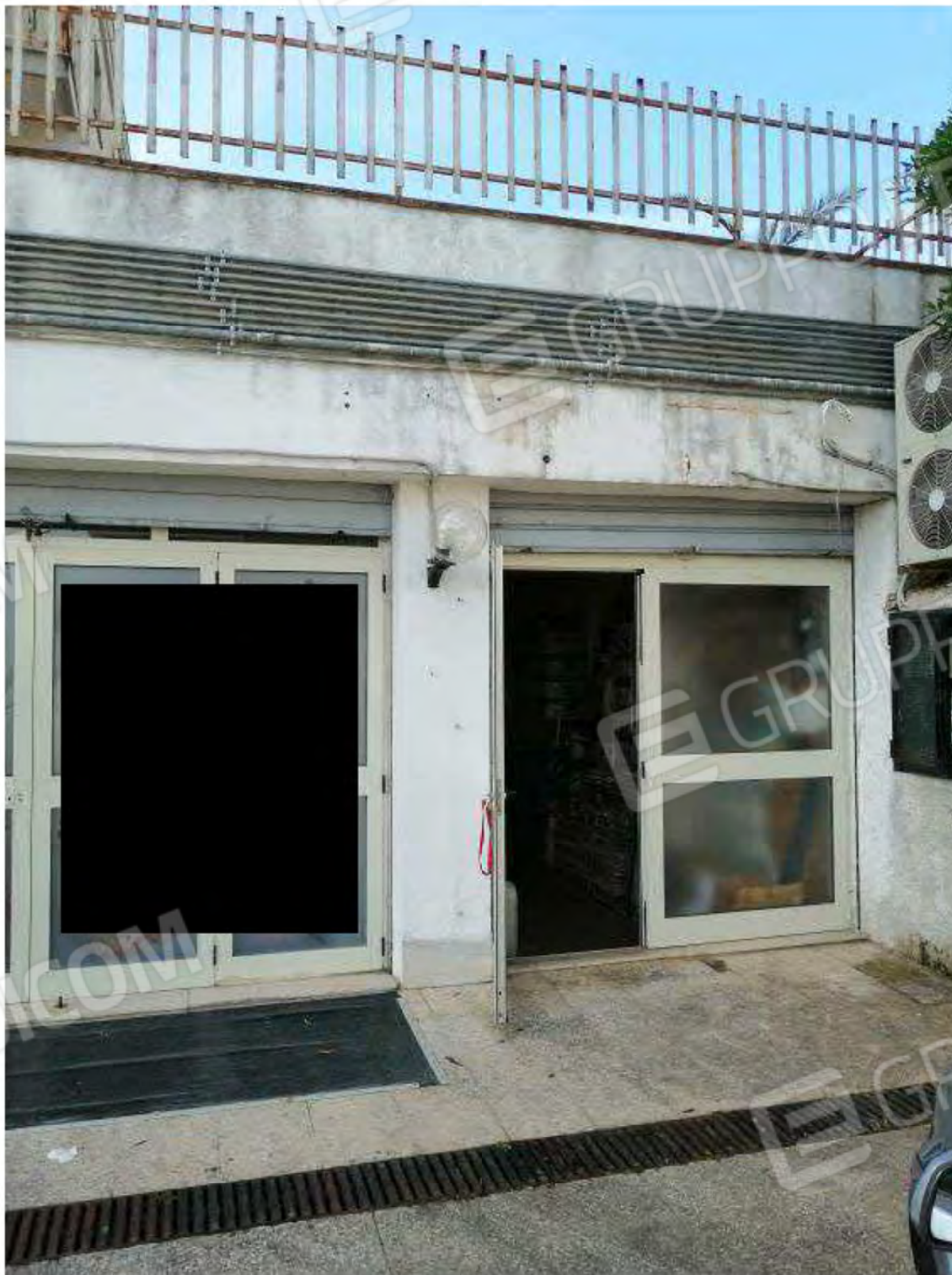
Foto 1 - Vista esterna Lato Nord (Sub. 1)
