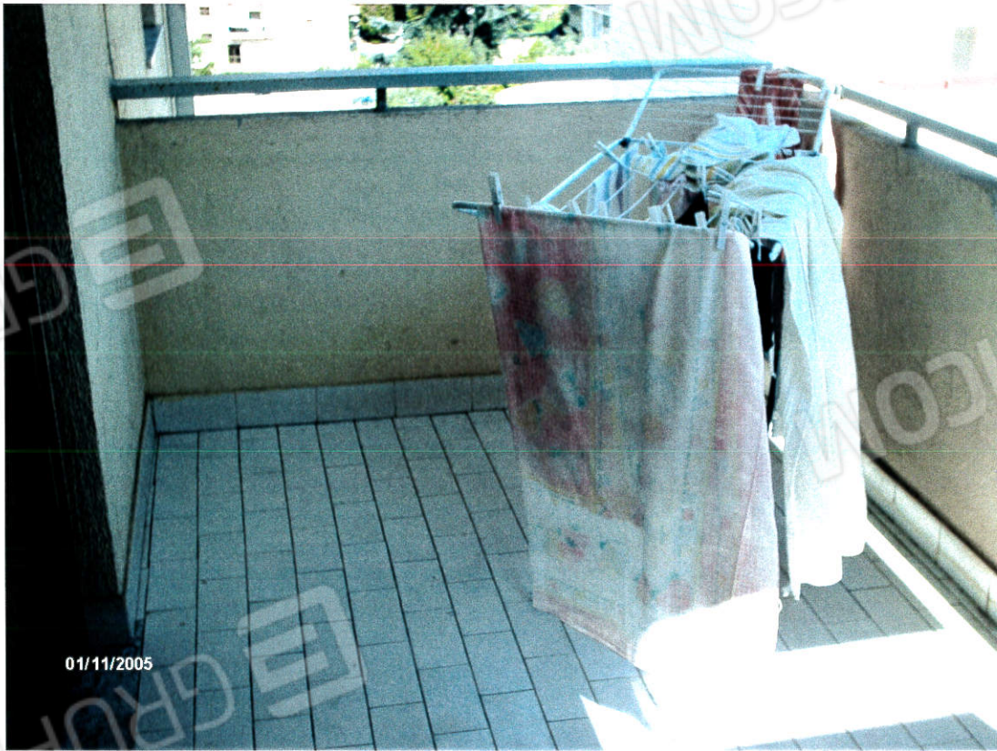
Foglio 39 p.la 165 sub 100 balcone
