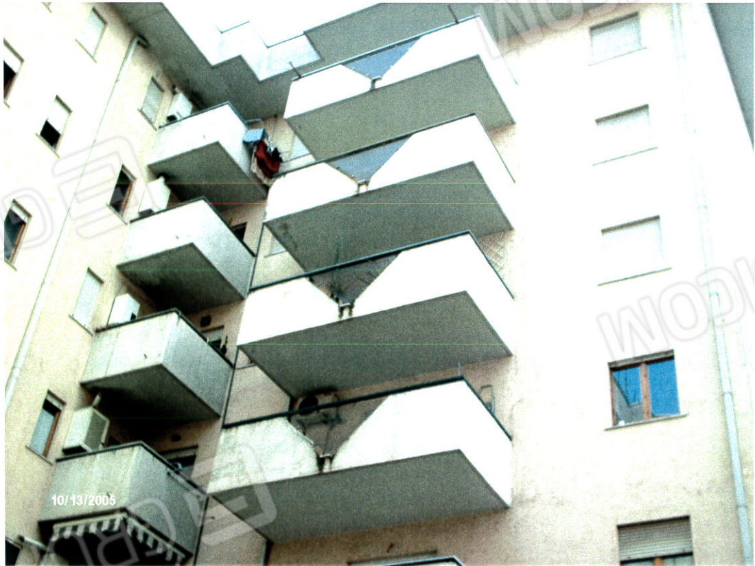
Foglio 39 p.lla 165 sub 91 esterno
