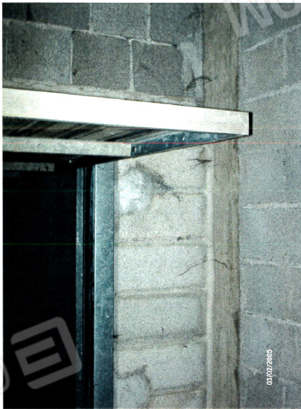
Foglio 39 p.la 165 sub 201 interno
