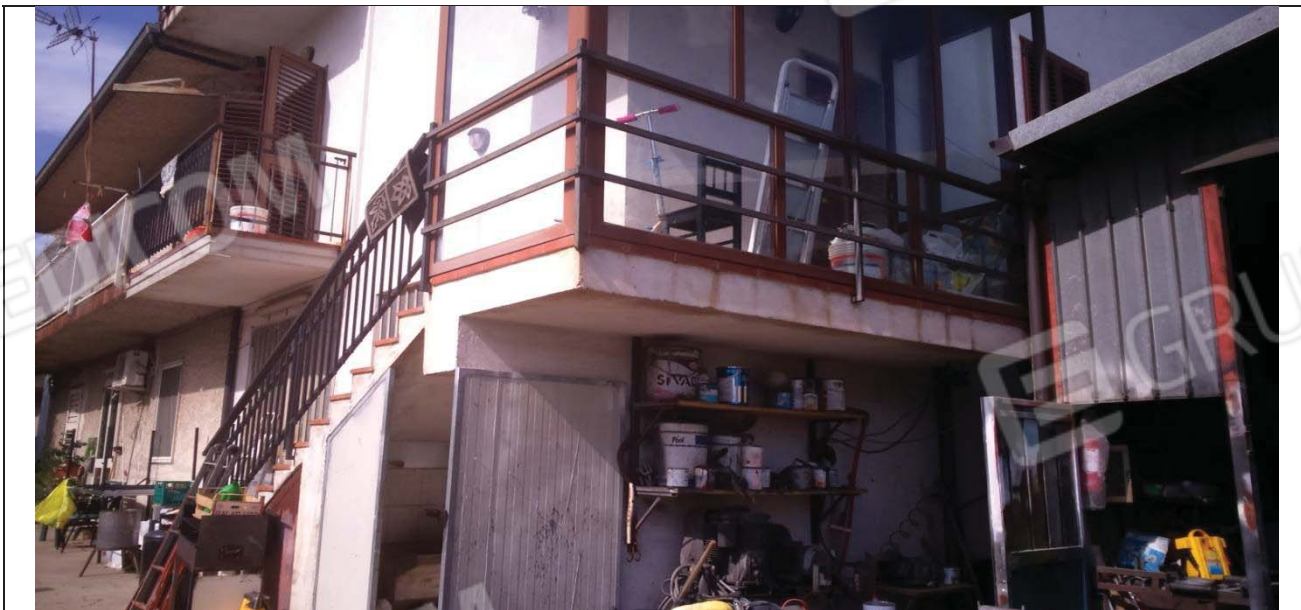
Scala di accesso
