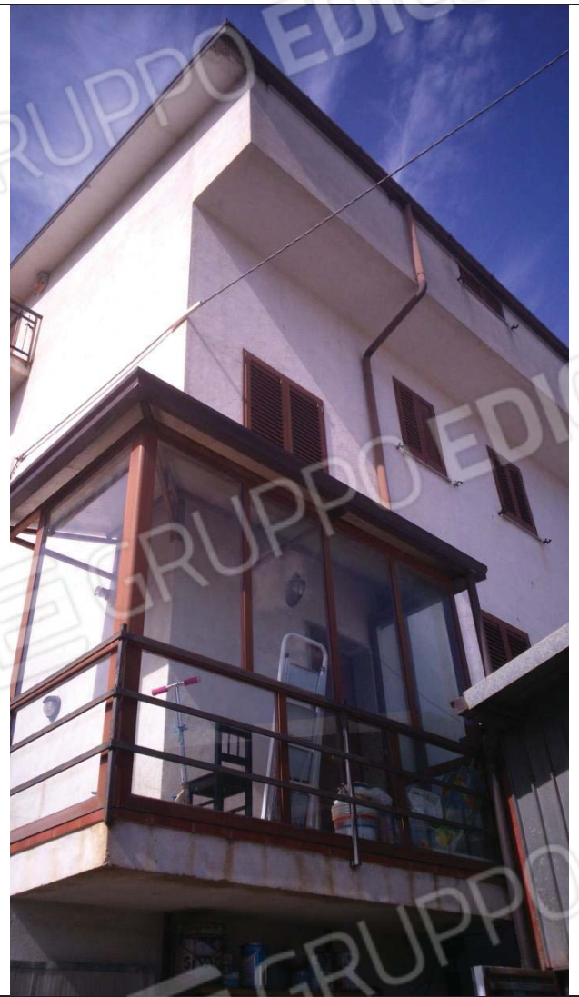
Accesso unità immobiliare
