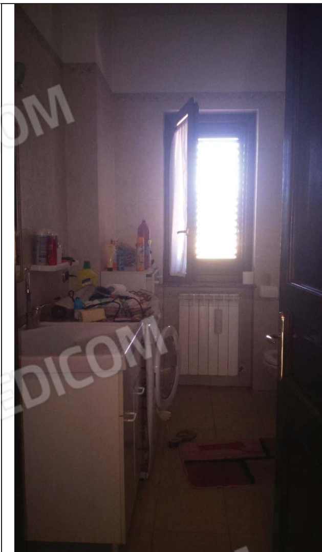
Bagno piano primo
