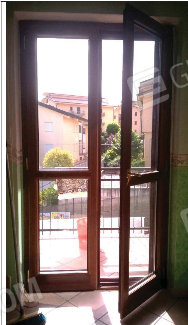
Balcone vano scala piano primo
