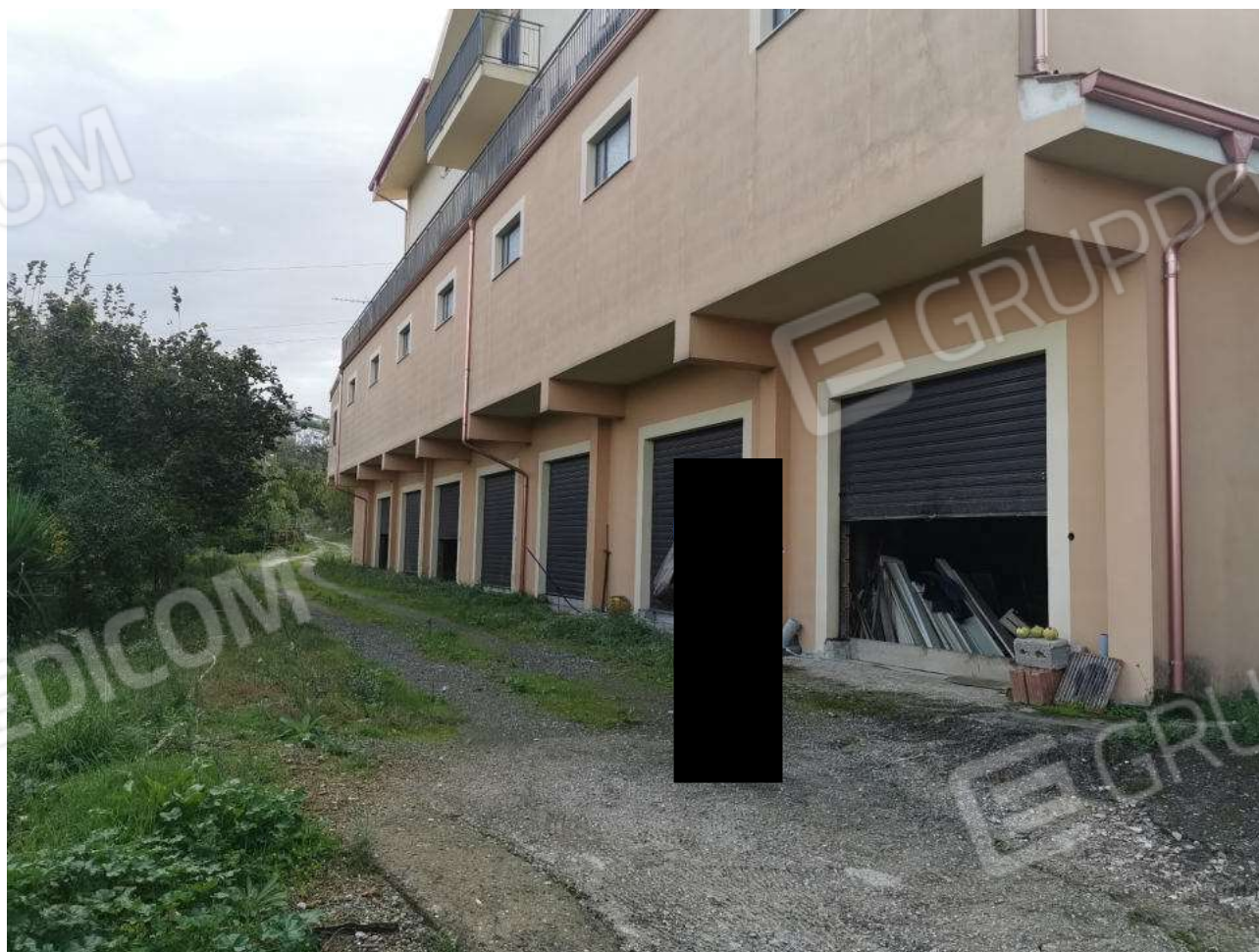
Foto 26: Lotto 9 - Fg. 2 P.Ila 390 sub. 3 – vista esterno.
