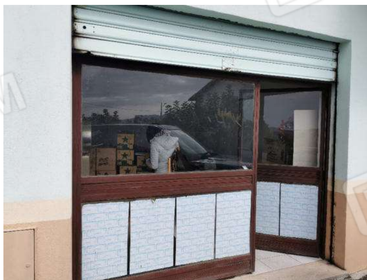
Foto 18: Lotto 8 - Fg. 2 P.Ila 390 sub. 7 - vista ingresso.
