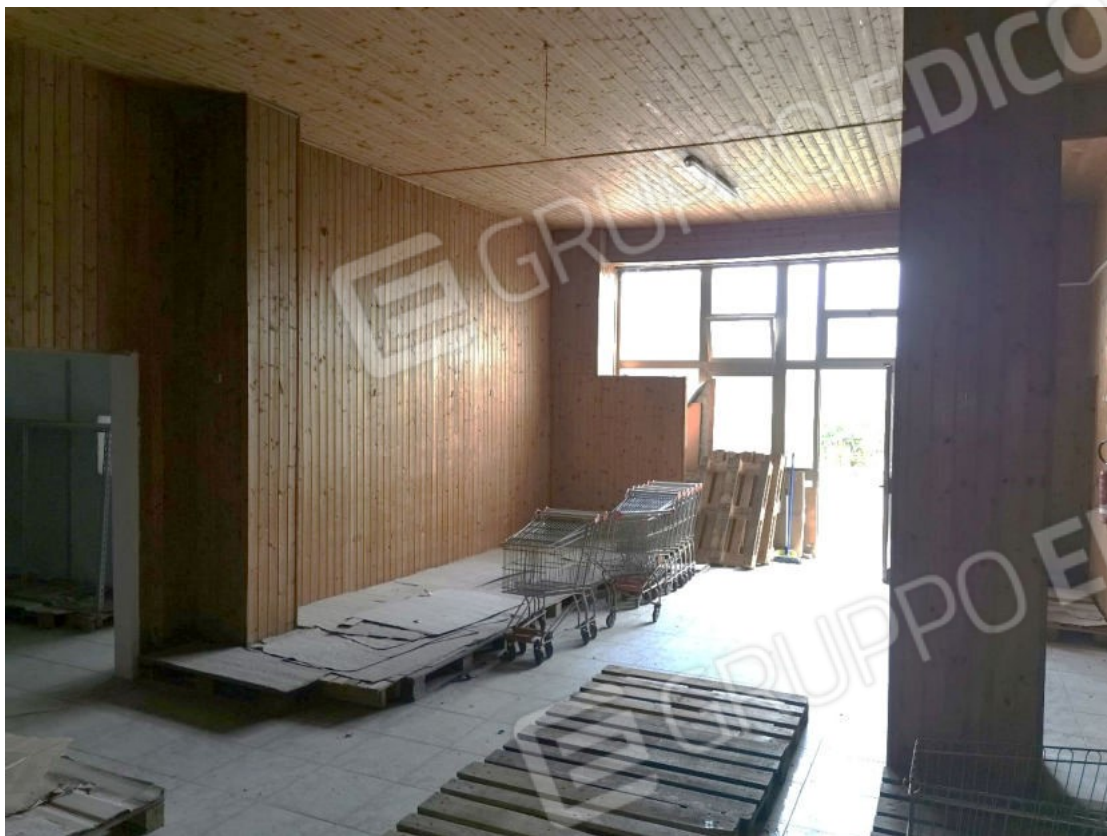
Foto 3: Lotto 1 - Fg. 2 P.Ila 309 sub. 15 - vista ingresso dall'interno.
