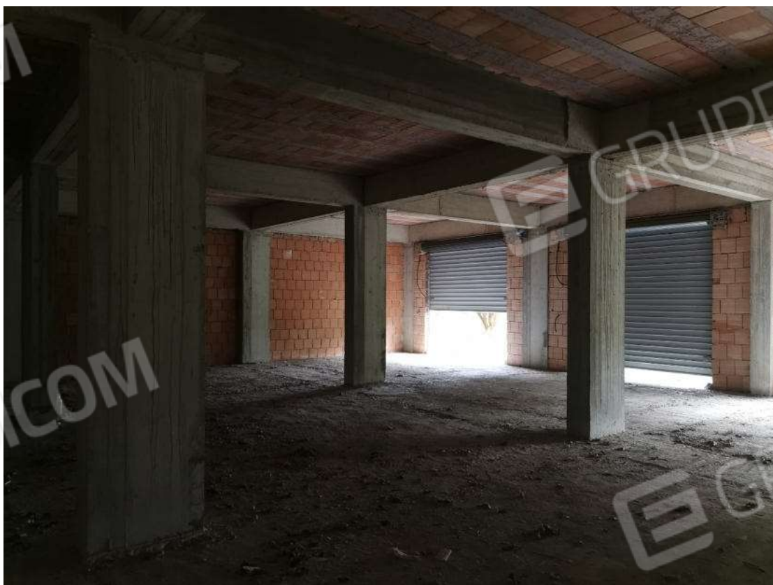
Foto 24: Lotto 9 - Fg. 2 P.Ila 390 sub. 3 – vista interno.
