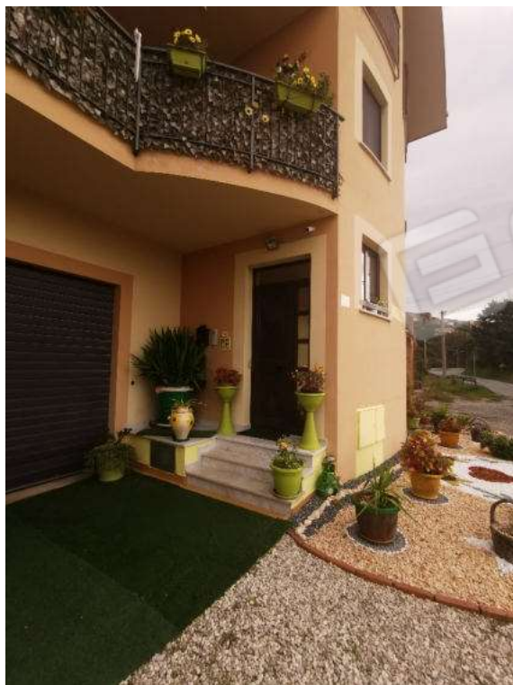
Foto 27-28: Lotto 10 - Fg. 2 P.Illa 390 sub. 6 – portone ingresso su via Lupia e scala accesso.
