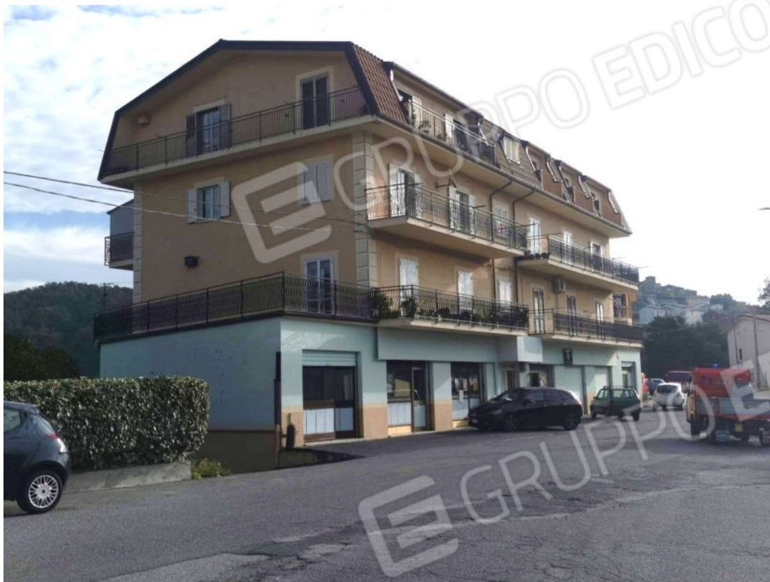
Foto 1: Immobile Comune di Scigliano - Fg. 2 P.Ila 309 – Vista da Via Lupia.
