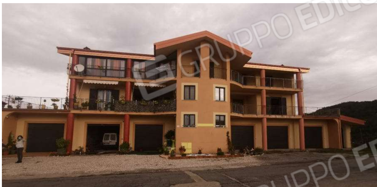
Foto 21: Immobile Comune di Scigliano - Fg. 2 P.Ila 390 – Vista da Via Lupia.
