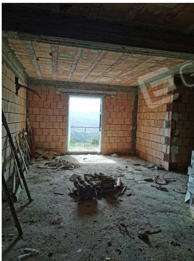
Foto 31: Lotto 10 - Fg. 2 P.IIa 390 sub. 6 – vista interno piano secondo.
