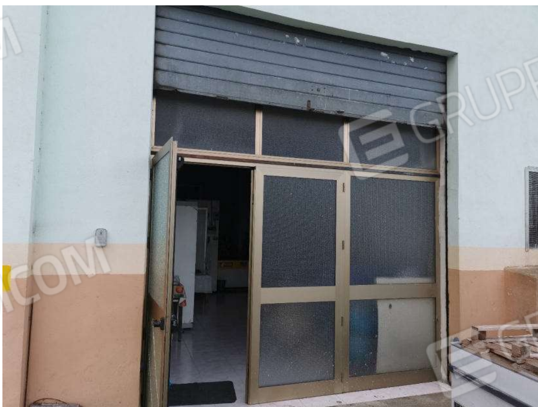
Foto 10: Lotto 4 - Fg. 2 P.Ila 309 sub. 19 - vista esterna.
