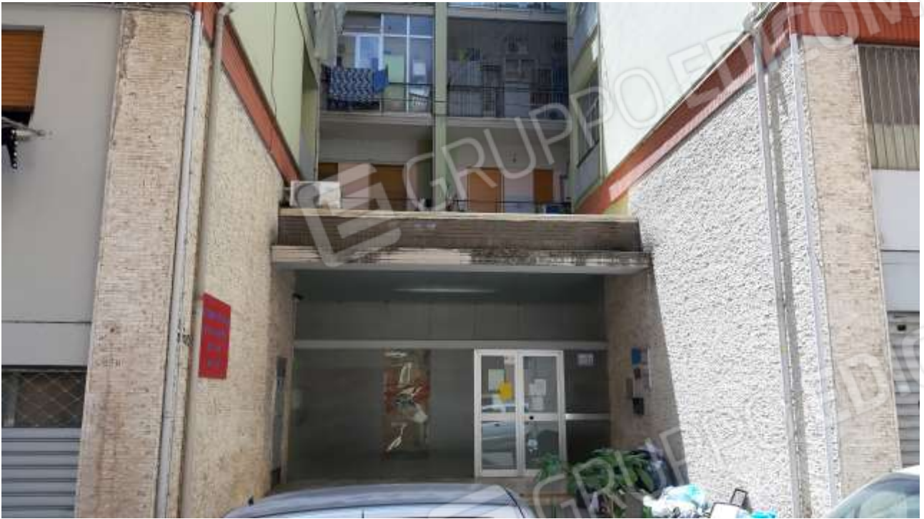
Foto 1 – Portone di ingresso condominiale da via Fagiani
