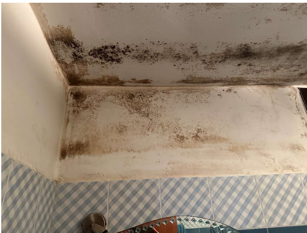
Foto 12: Piano interrato: WC - particolare.
