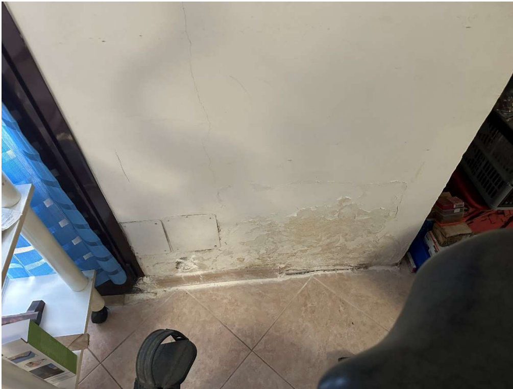
Foto 15: Piano Interrato: soggiorno - particolare.
