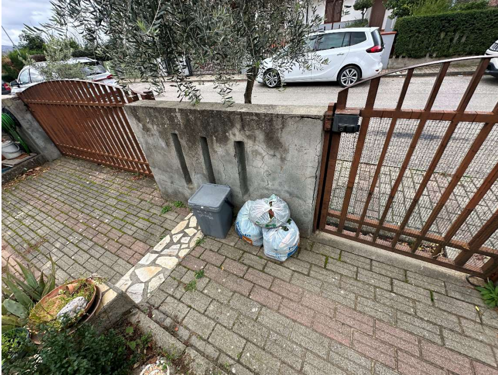
Foto 5: Particolare muretto ingresso carrabile/pedonale.
