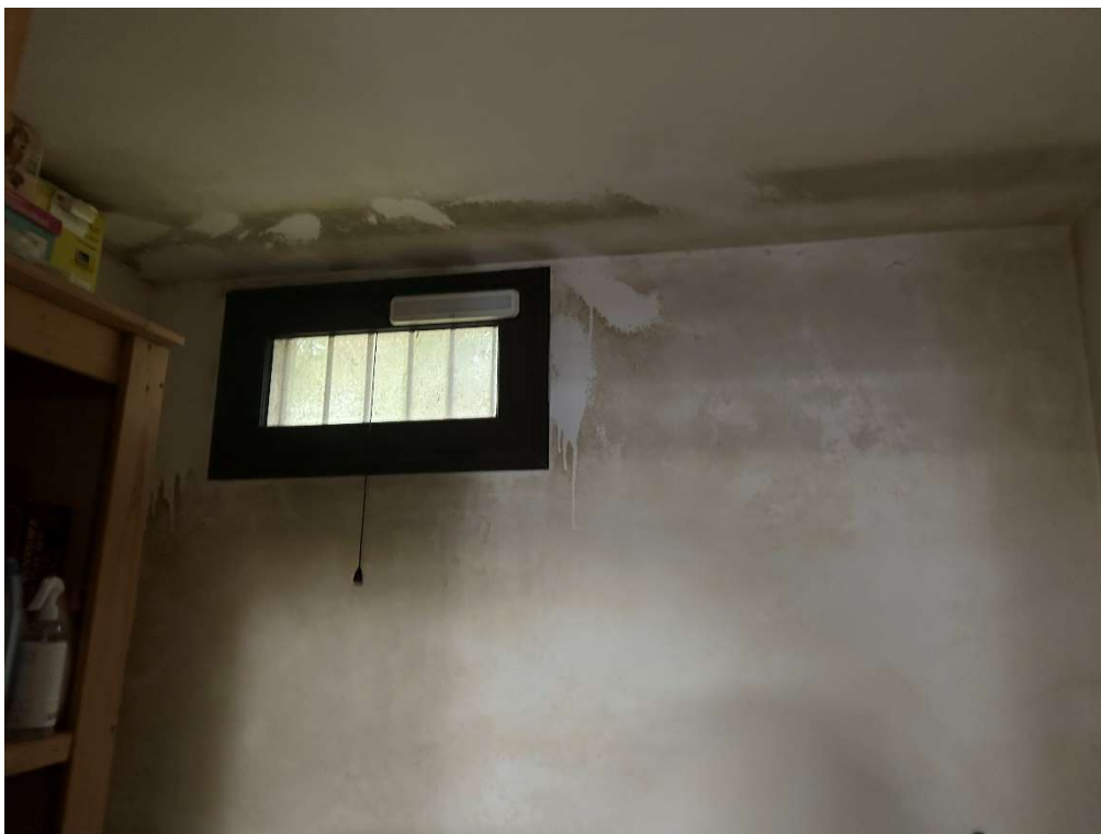
Foto 9: Piano interrato: disimpegno WC.
