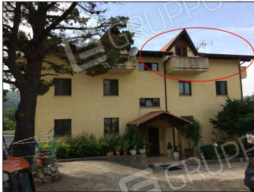
Foto n. 1: Esterno dell'immobile Prospetto Principale
