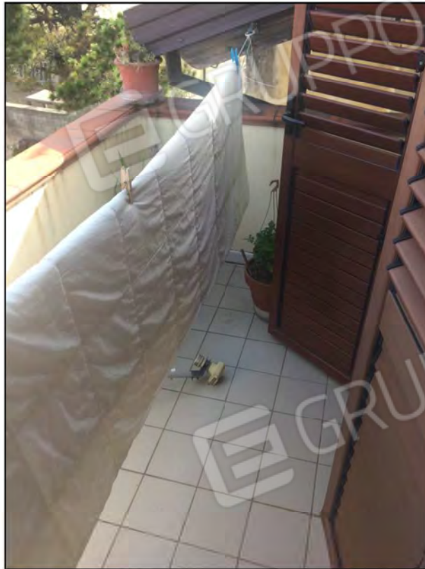
Foto n. 18: Esterno dell'immobile Balcone Lato Cortile
