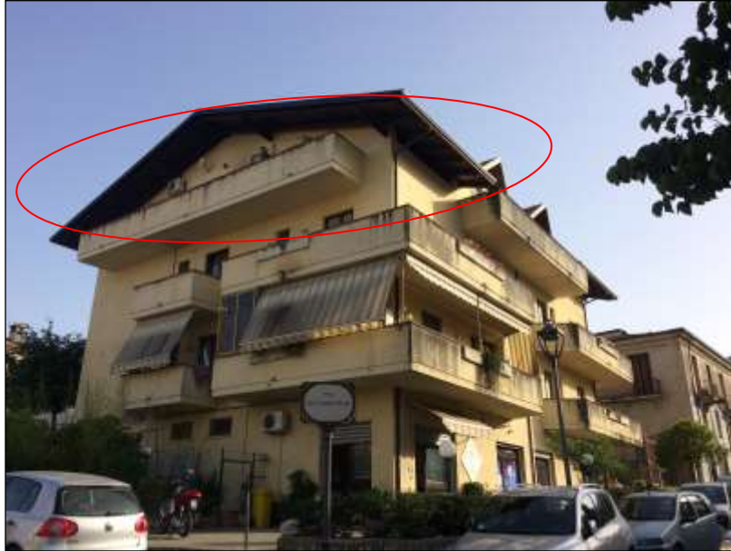
Foto n. 15: Esterno dell'immobile Prospetto Lato Strada
