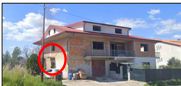
Fig. n. 4 – Accesso alla scala interna (Prospetto Sud – Est)
