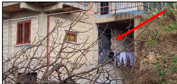
Fig. n. 5 – Accesso alla porzione immobiliare pignorata
