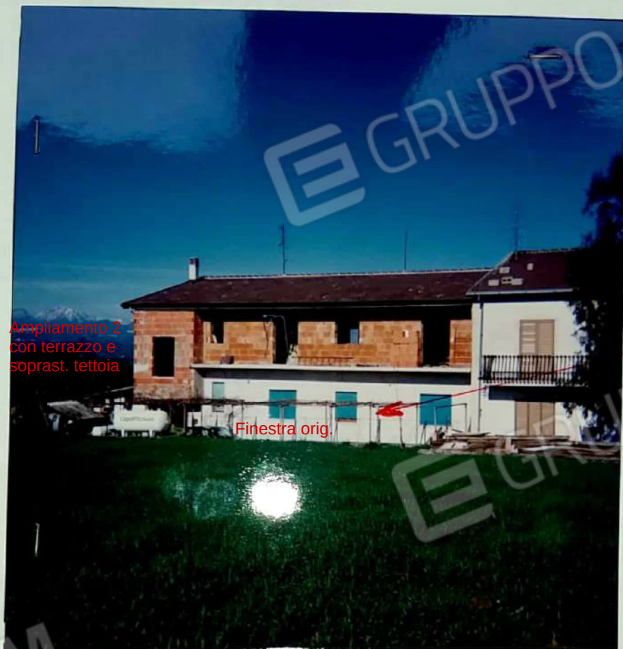
Foto n. 1 - Piano Terra, lato Est
