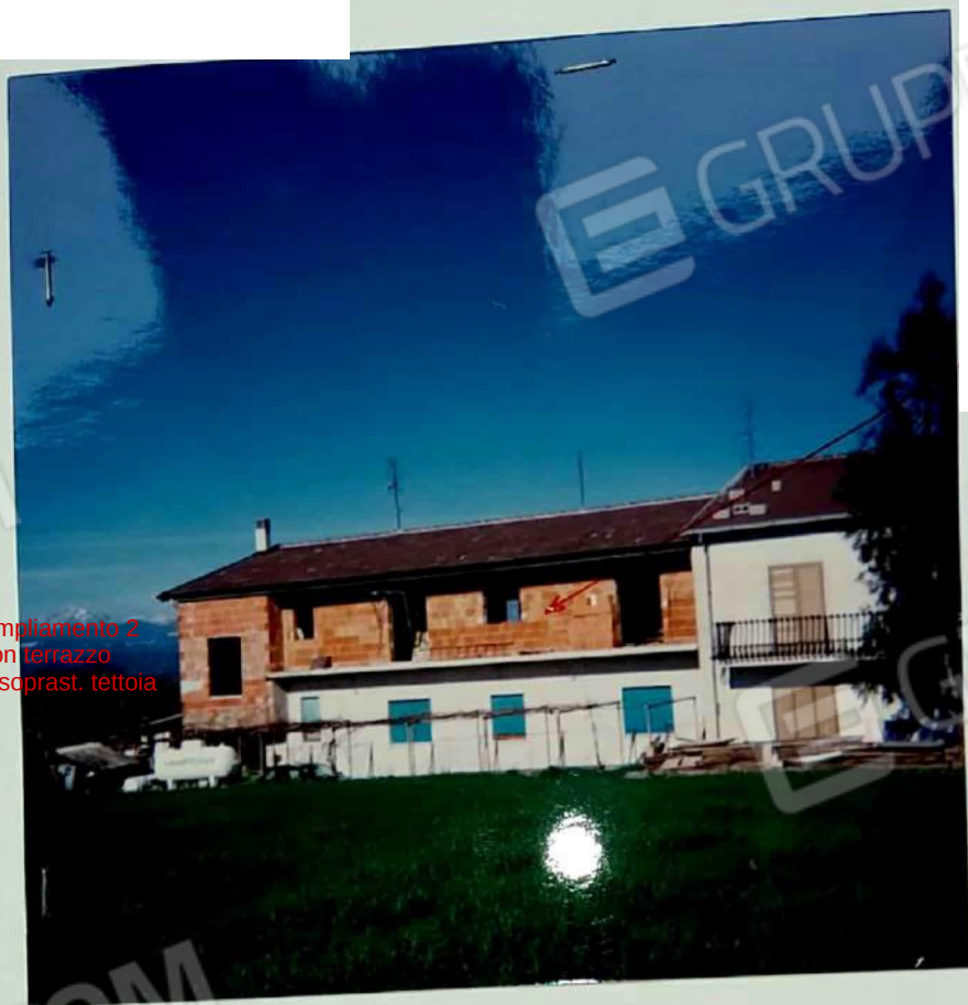
Foto n. 3 - Piano Primo, Lato Est
