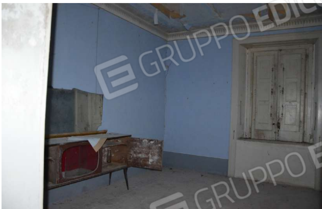
FOTO N. 59- Piano Primo Camera
