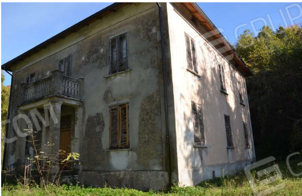
FOTO N. 46 Fabbricato in Rogliano
