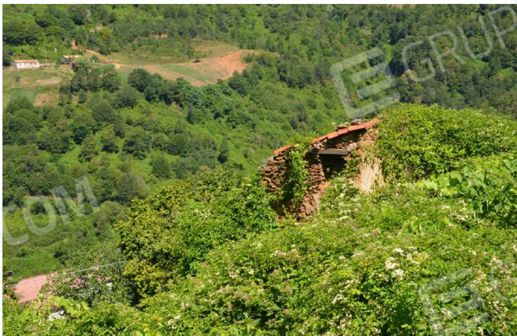
FOTO N. 64 -Rogliano Rudere ex Fabbriato rurale foglio 10, particella 24
