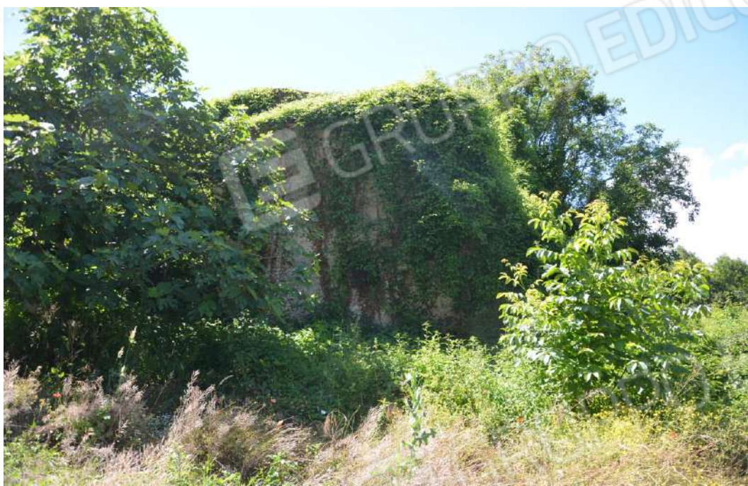
FOTO N. 65- Rogliano Rudere ex Fabbricato rurale foglio 10, particella 25
