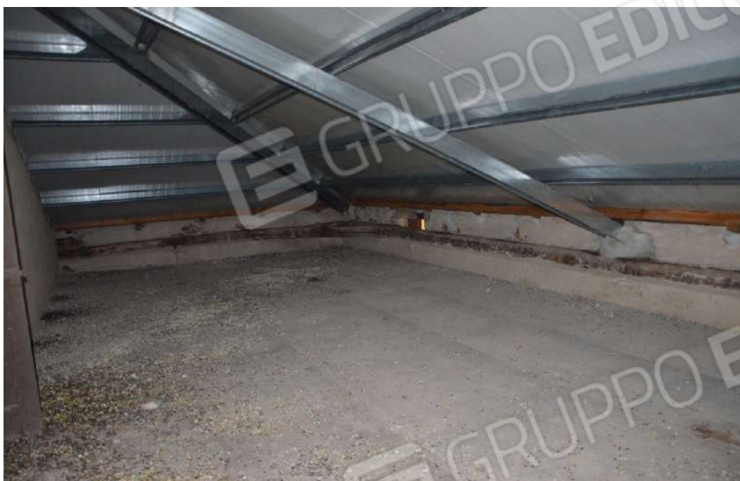
FOTO N. 63- Piano Secondo Sottotetto
