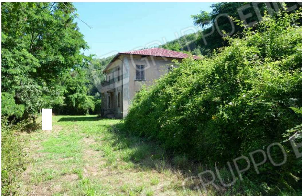
FOTO N. 45 Fabbricato in Rogliano
