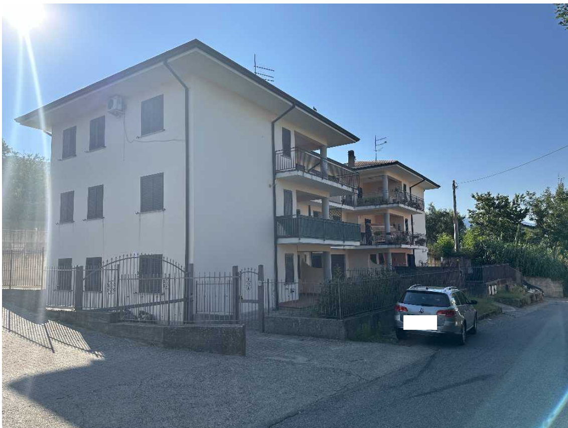
Foto 1: Vista esterna edificio.
