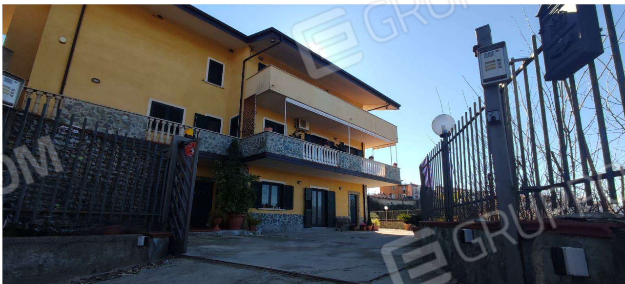
vista ingresso da cancello
