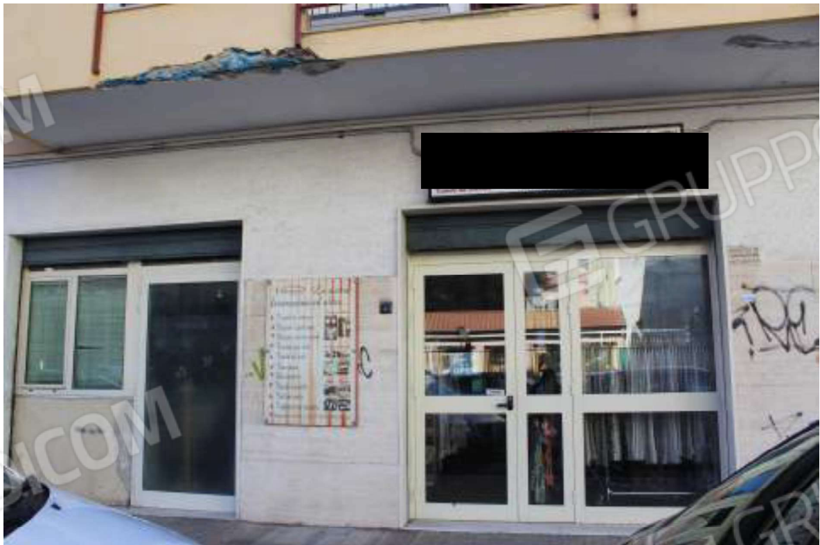
Foto 10.2.58_Vista Prospetto esterno
