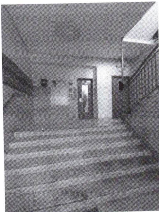
Vano scala con ascensore
