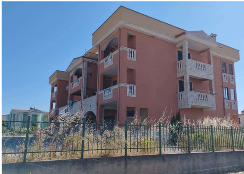
Foto esterno intero fabbricato.
