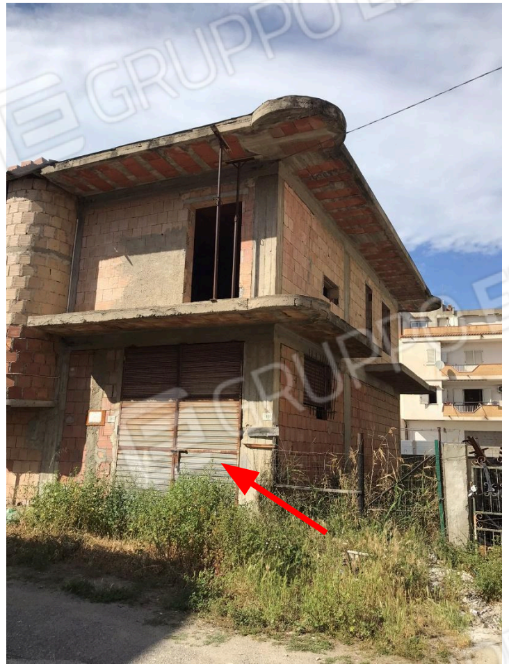
Accesso da Piano terra appartenente a terzi
