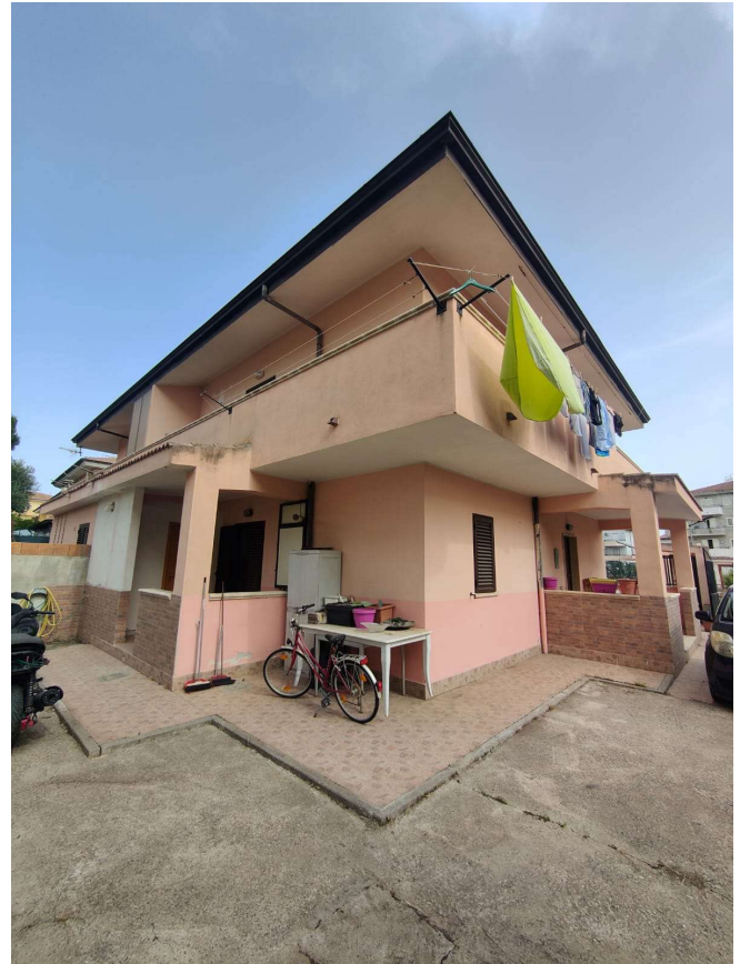
Vista laterale sulla veranda della cucina
