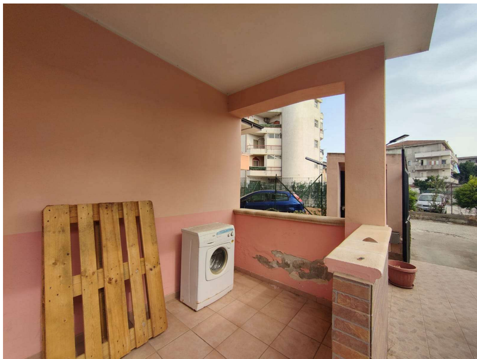
Vista sulla veranda di ingresso
