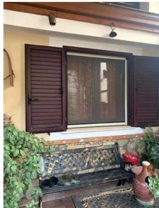
Facciata anteriore parziale.
