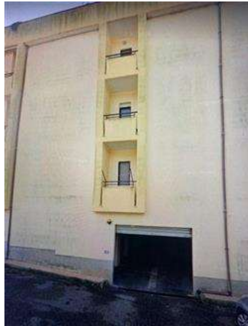
Facciata nord con ingresso ai box.
