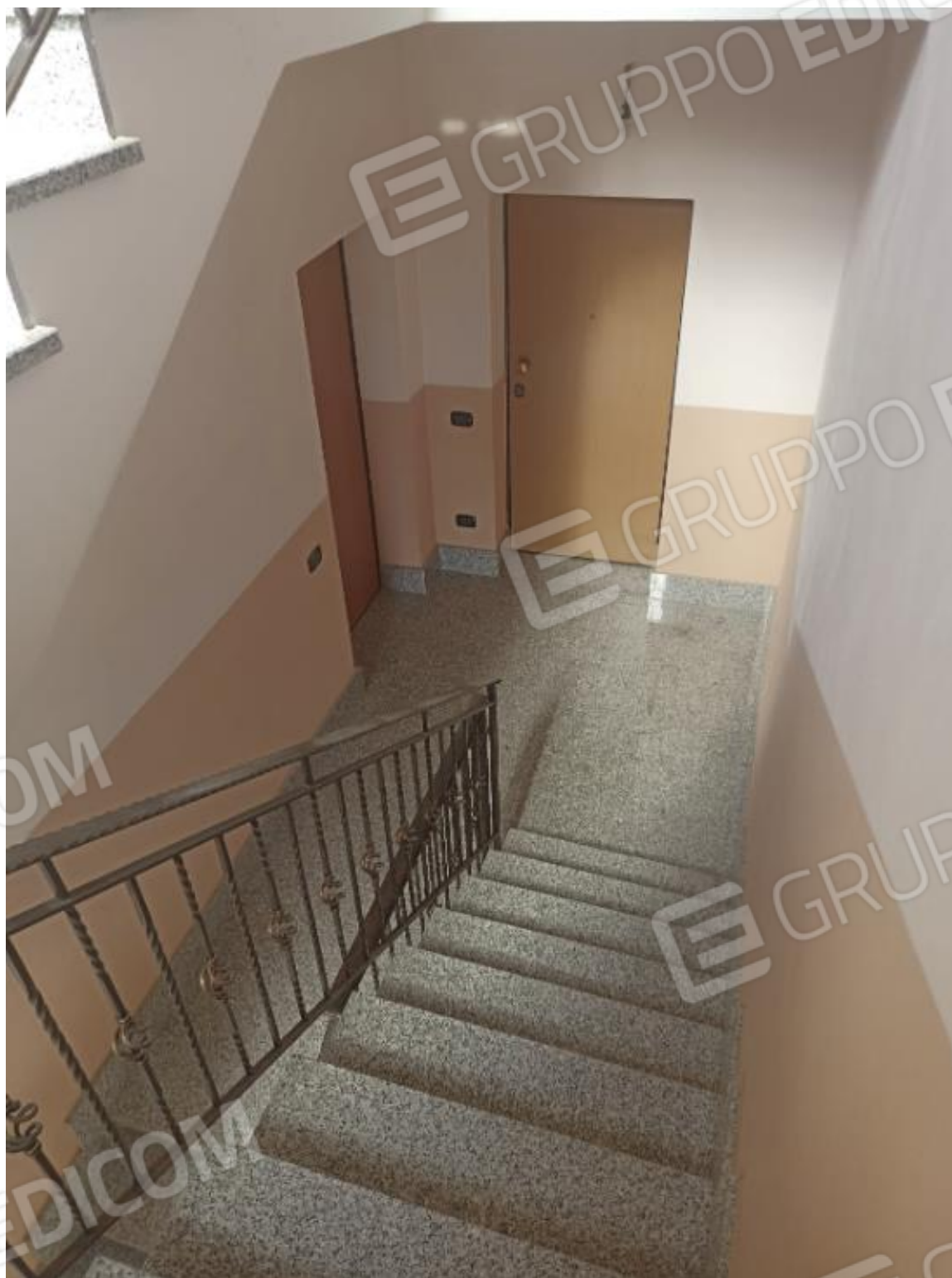
FOTO SUB. 7 PIANO SECONDO LATO SX - LOTTO N. 3
