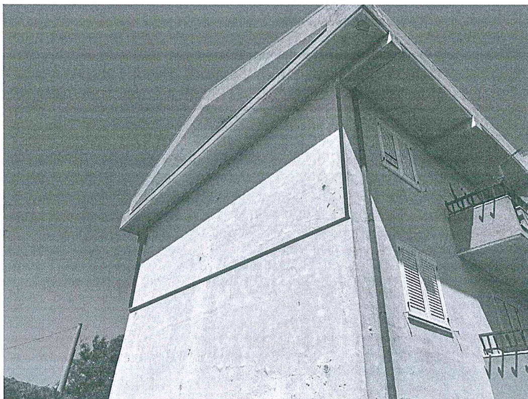
Foto n. 4 – Facciata Sud – Sub. 9
