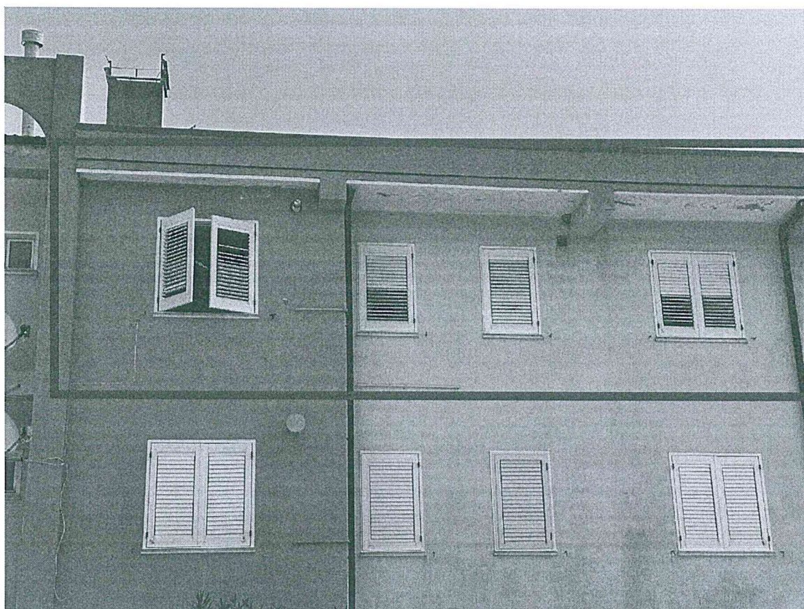
Foto n. 2 – Facciata sud/Ovest – Sub.9
