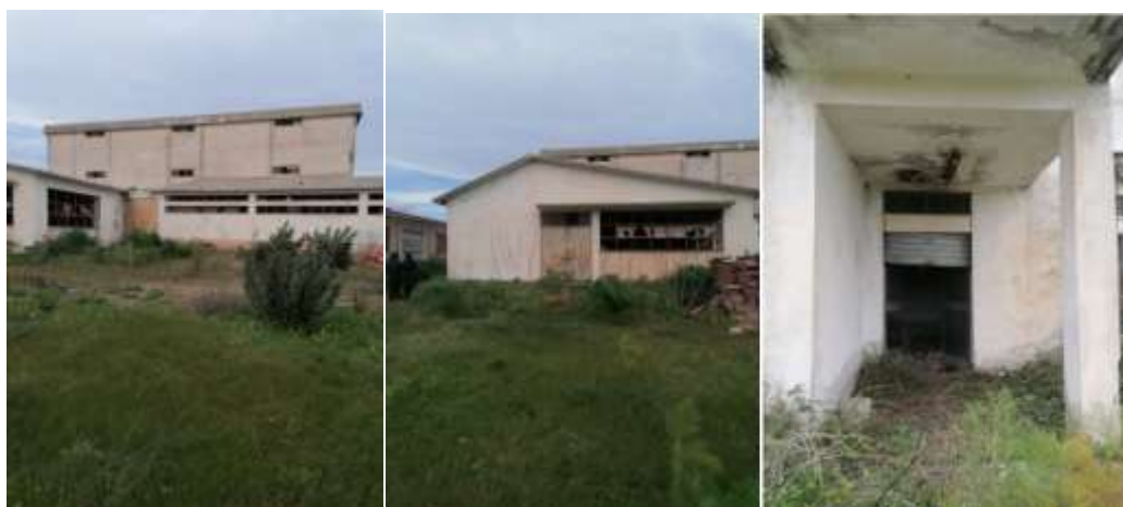
Fabbricato a Piano Terra (imbottigliamento, confezionamento ecc.).
