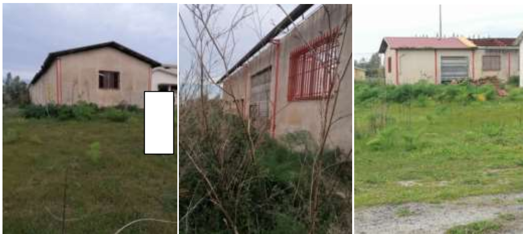
Capannone adibito a deposito e stoccaggio del vino
