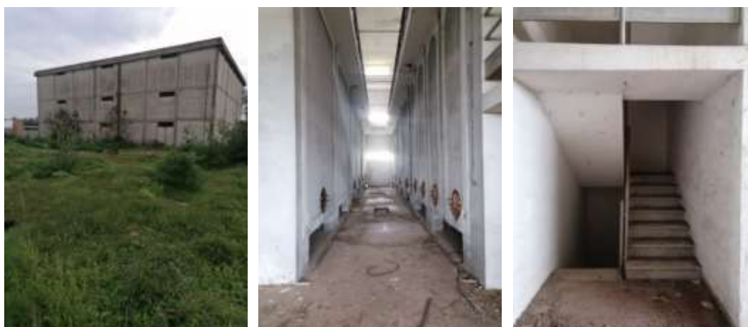
Fabbricato a tre livelli + scantinato (adibito ad ex enopolio)
