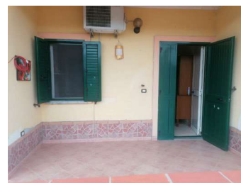
porta d'ingresso dell'appartamento a P. T.
