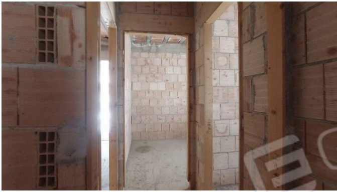
Inizio immobile oggetto di esecuzione - Piano Primo
