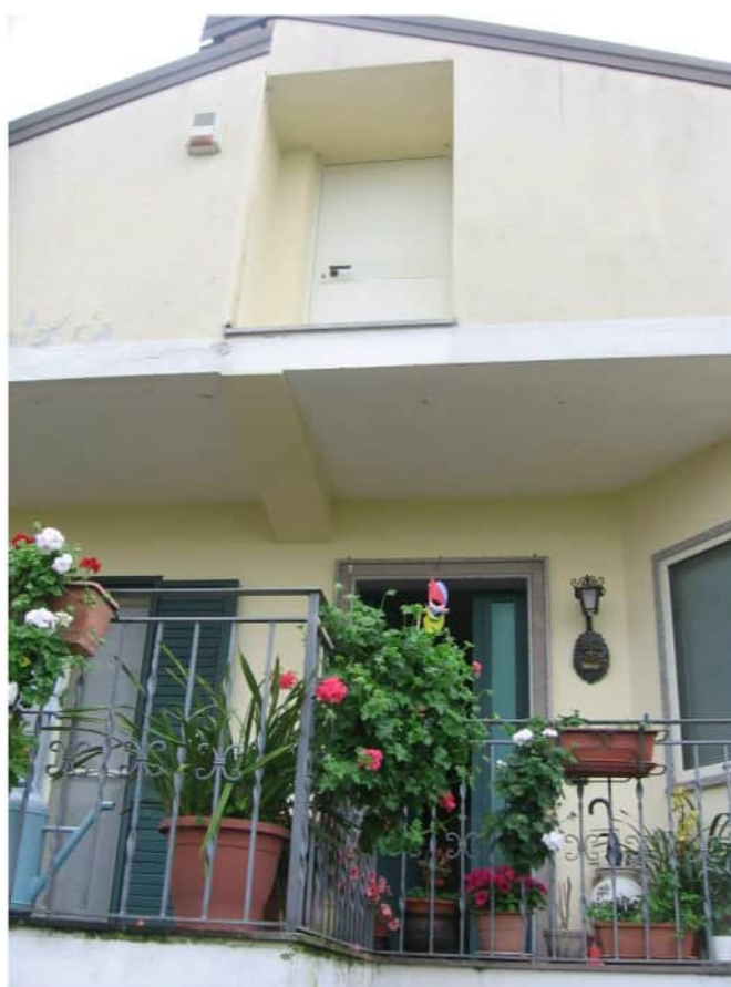
Prospetto Nord del fabbricato
