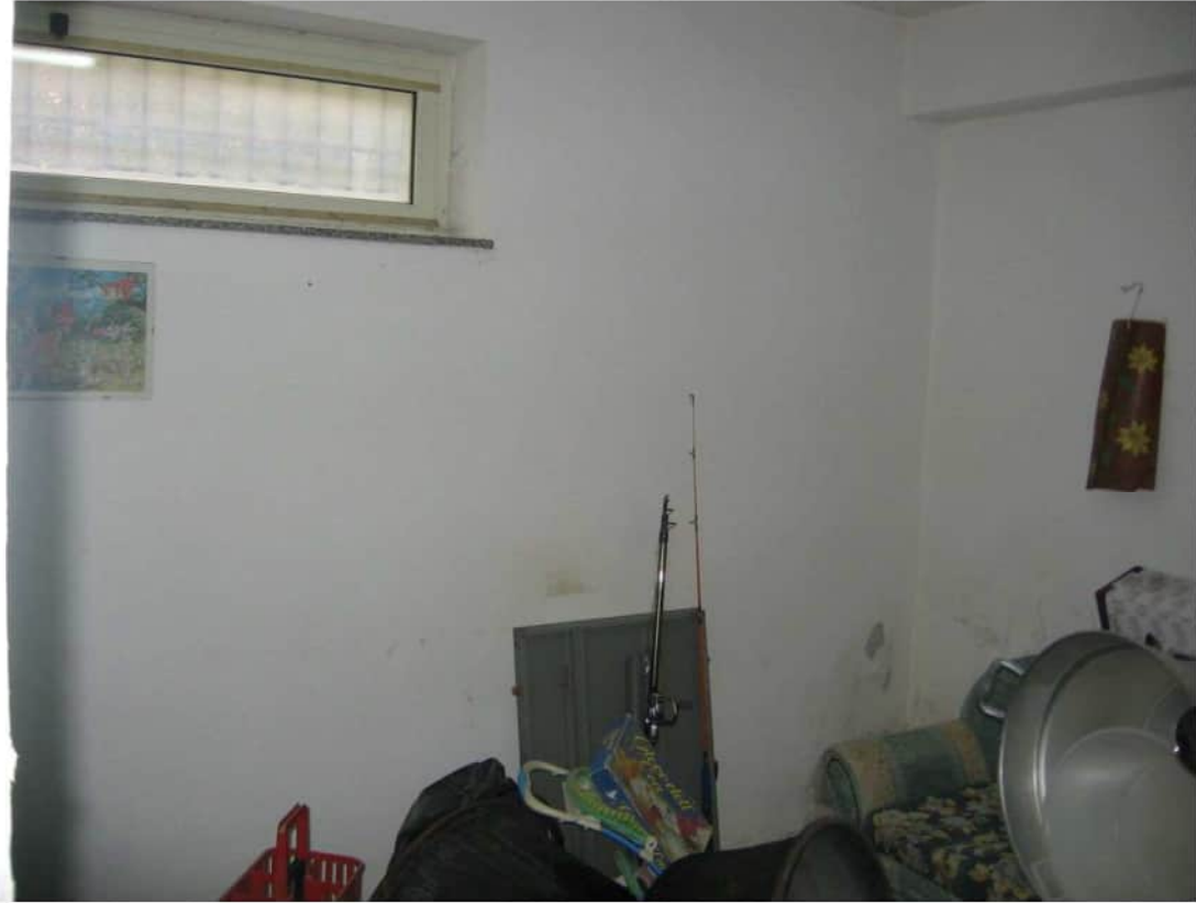
Deposito piano seminterrato
