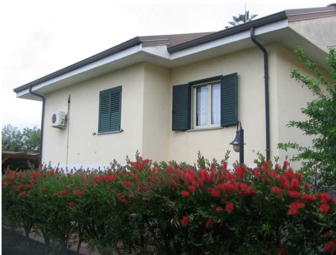
Prospetto Ovest del fabbricato
