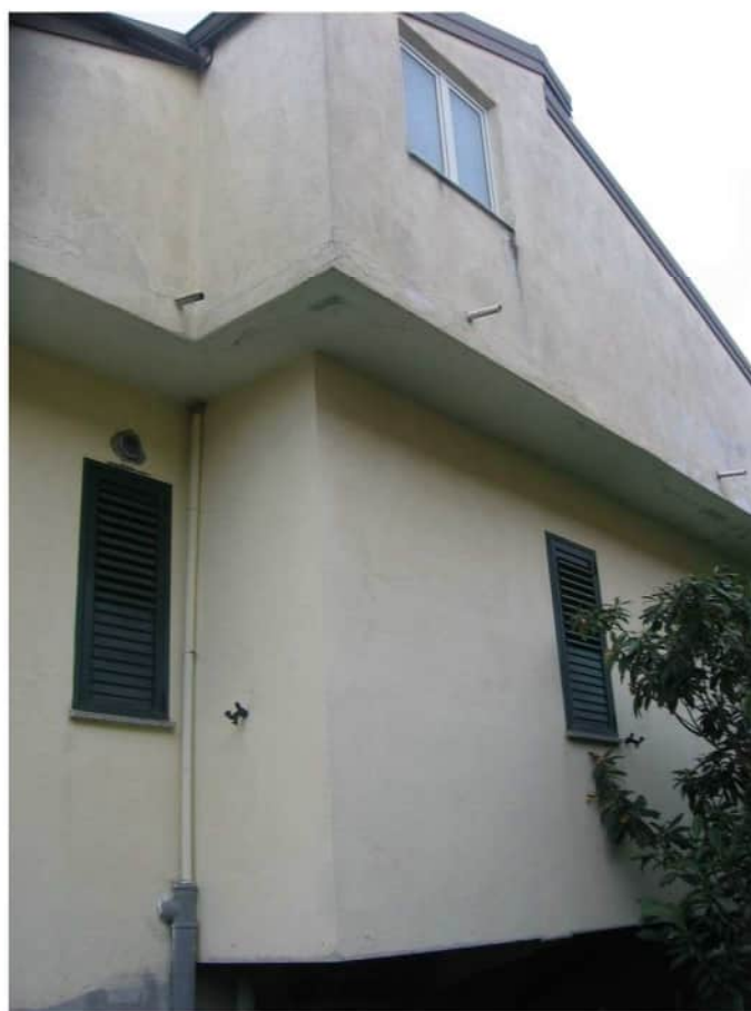
Prospetto Sud del fabbricato
