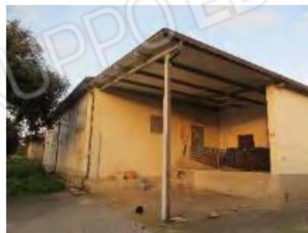
Foto n.°10 Prospetto ovest
