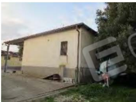
Foto n.°9 Prospetto sud
