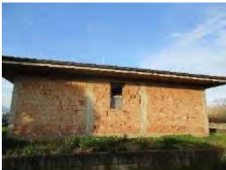
Foto n.°5 Prospetto sud
