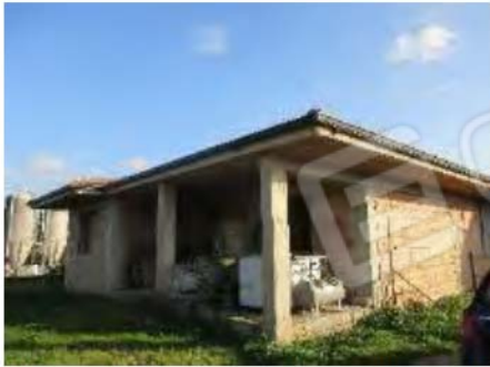
Foto n.°1 – Ingresso – Prospetto nord
