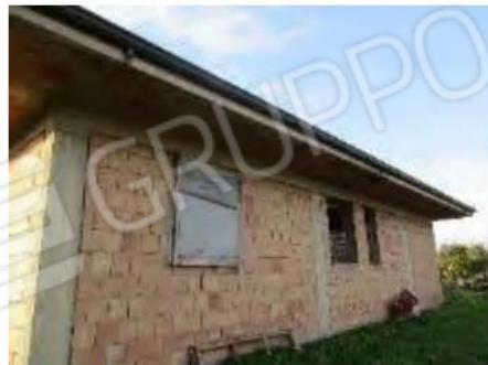
Foto n.°4 Prospetto ovest
