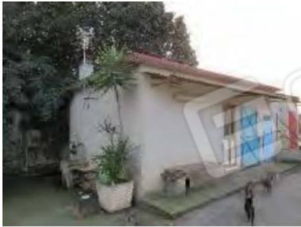
Foto n.°21 Particolare prospetto nord
