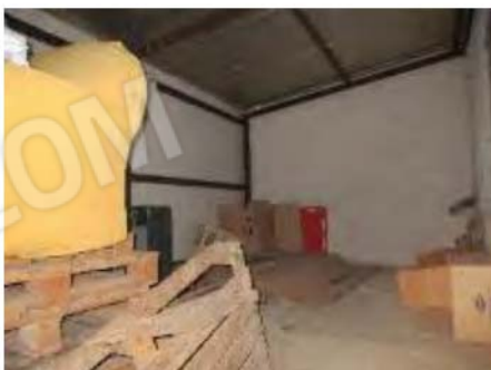
Foto n.°15 Particolare deposito
