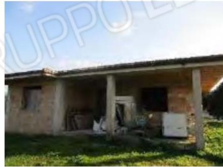
Foto n.°2 – Ingresso – Lato nord
