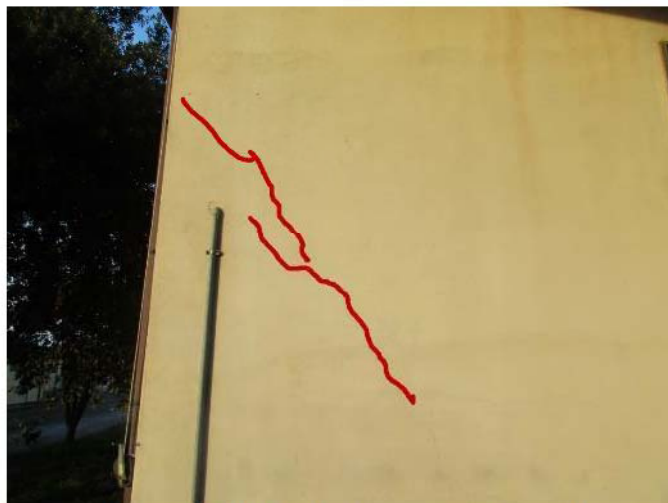
Foto n.1 – Stalla - Parete esterna – Lato sud
