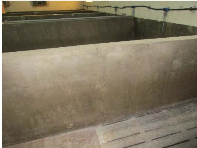
Foto n.15 – Stalla – Muro divisore tra il box 1 e il box 2
