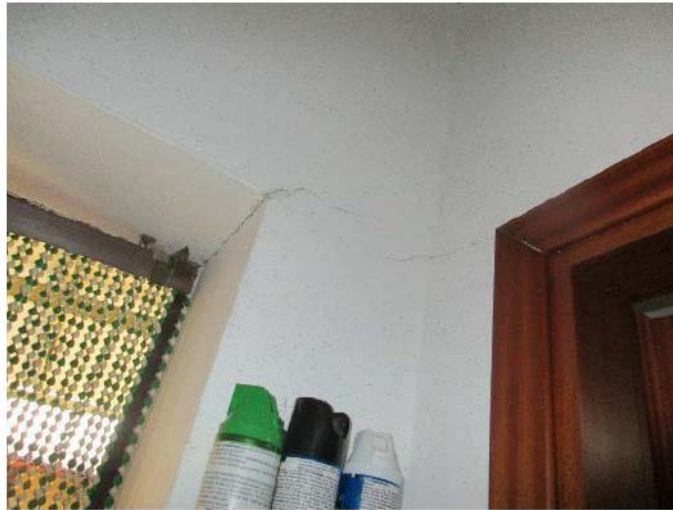
Foto n.9 – Disimpegno – Parte alta parete ovest – Lato interno
