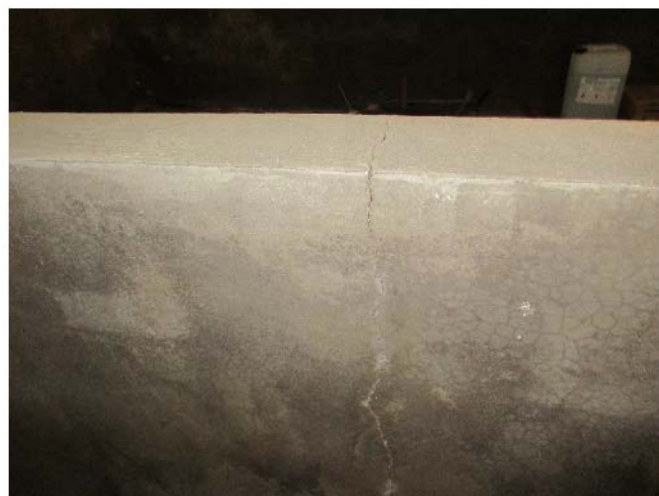
Foto n.14 – Stalla – Muro divisore tra il box 7 e il box 8
