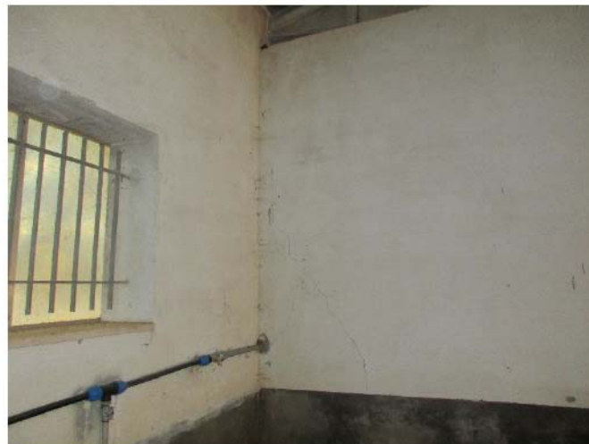
Foto n.13 – Stalla – Box 7 – Parete nord – Lato interno
