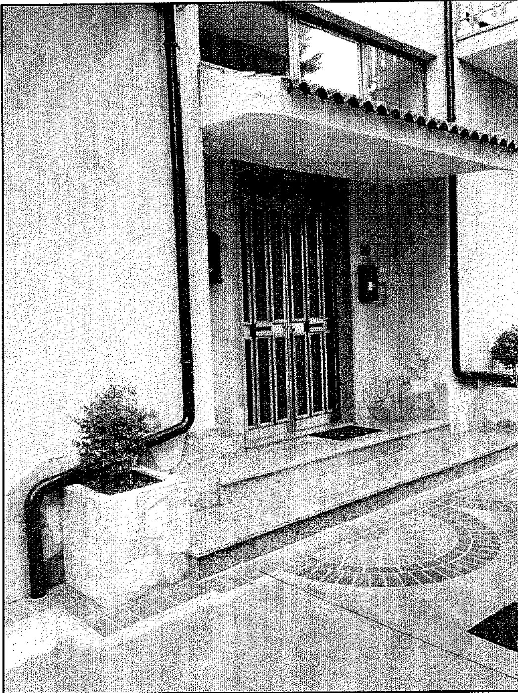
Foto 4: L'ingresso principale al fabbricato
