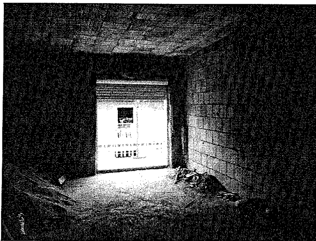
Foto n. 14: Uno degli ambienti della mansarda allo stato rustico
