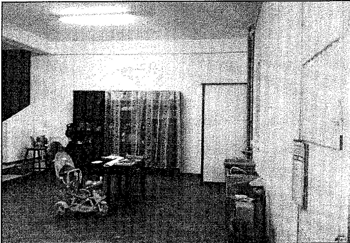
Foto 2: L'interno del locale autorimessa
