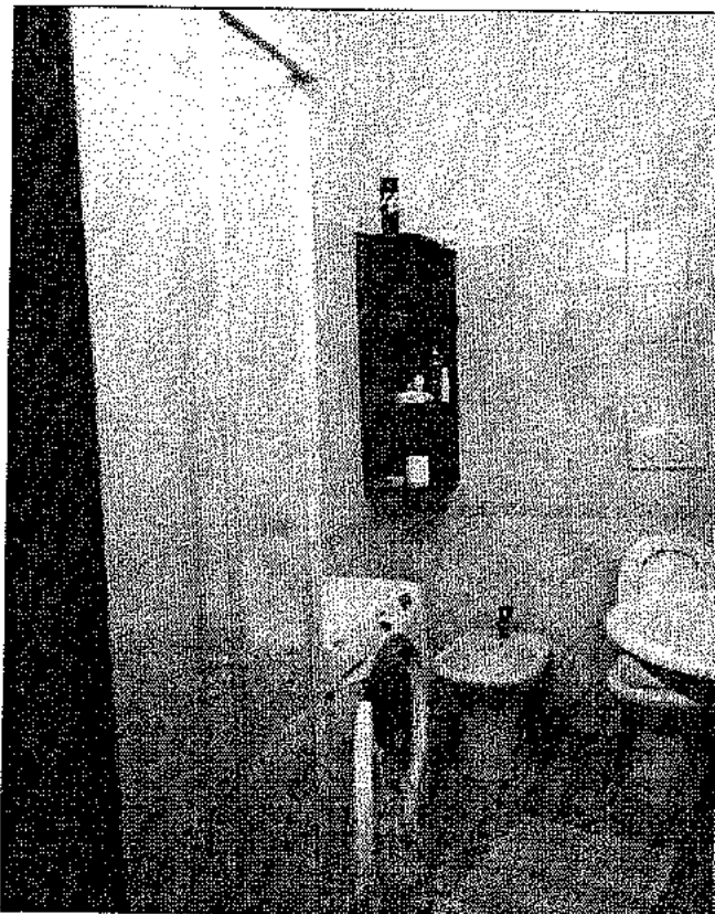
Foto n. 14: Mansarda: il servizio igienico (Part. 527 sub 8)
