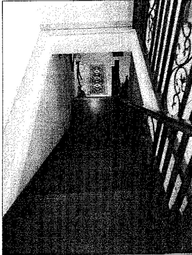
Foto n. 11: Vista della scala lignea dalla mansarda
