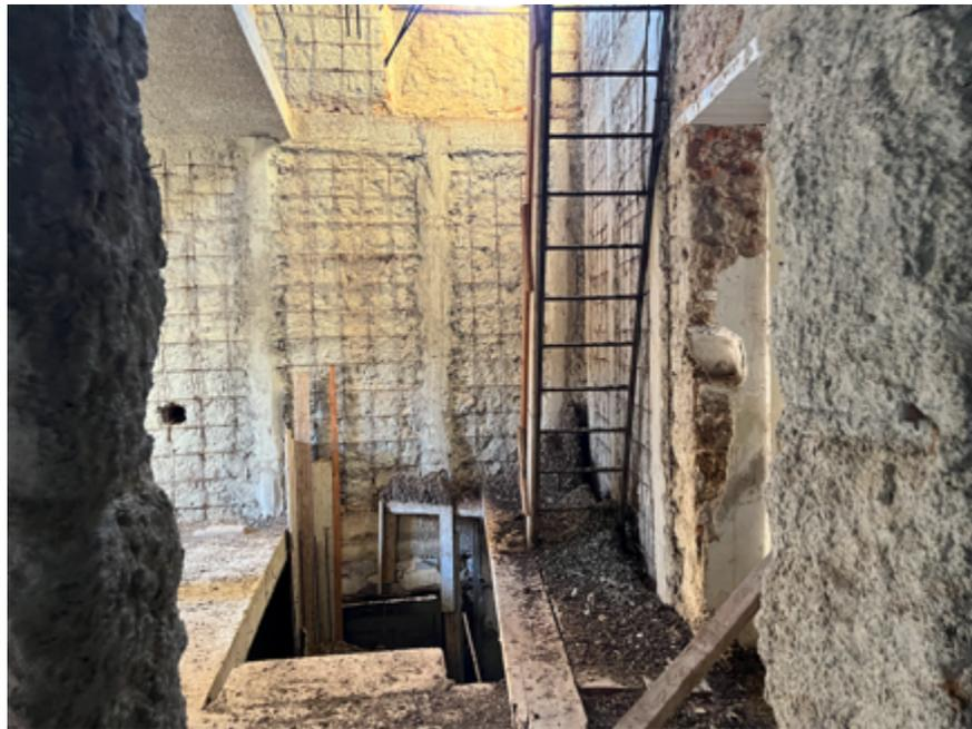
**Figura 17 Sub 3 piano secondo \_ Scala in ferro per accedere al sottotetto**
