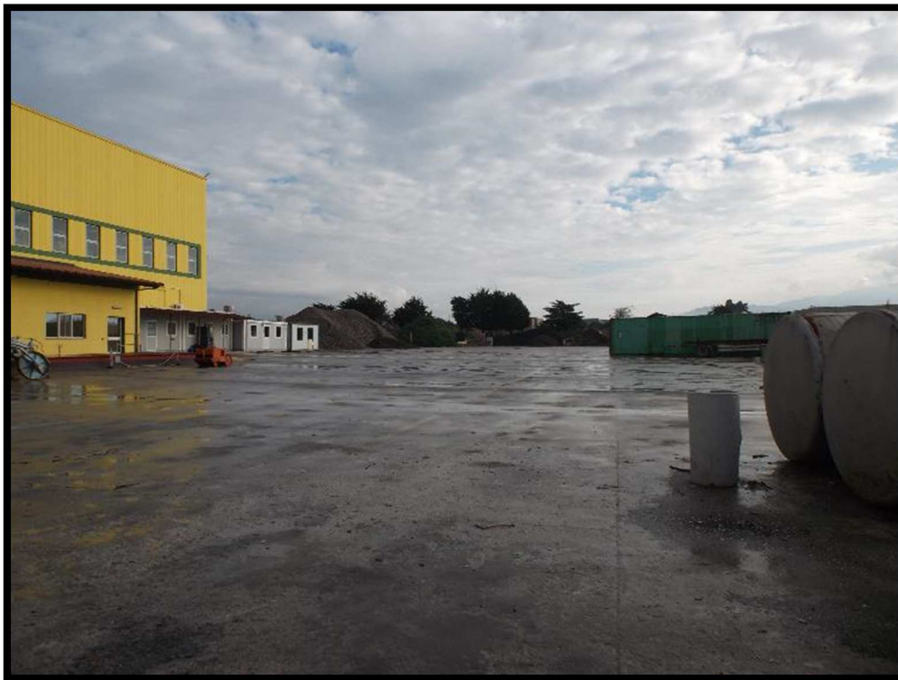
Foto n.*1- Particolare piazzale totalmente coperto
