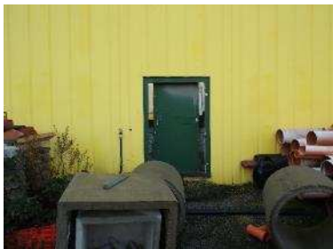
Foto n.°6 Porta di sicurezza lato nord
