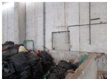
Foto n.°8 Porta di sicurezza lato sud
