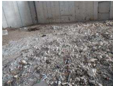
Foto n.°10 pavimentazione demolita
