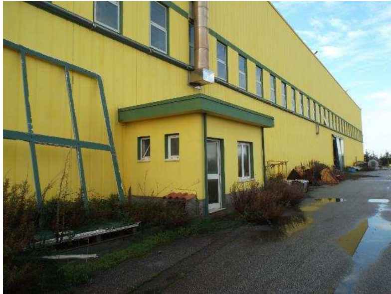
Foto n.*23- Particolare locale costruito in adiacenza al capannone 1- Prospetto nord
