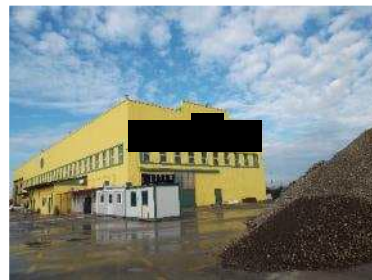
Foto n.°7 Porte lato est
