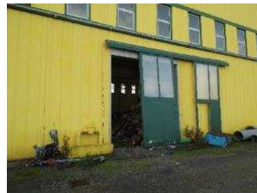
Foto n.°5 Porta carrabile lato nord
