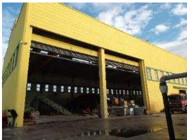
Foto n.°4 Porta carrabile lato sud
