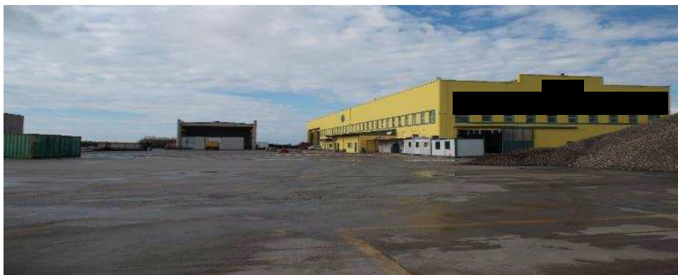
Foto n.°26- Capannone 2
