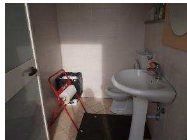
Foto 22 - Bagno con ingresso dalla corte esterna
