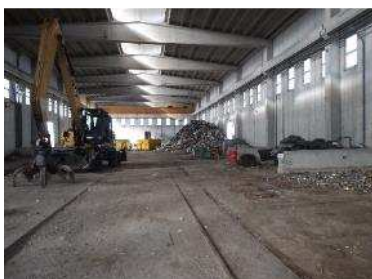
Foto n.°13 Particolare carro ponte
