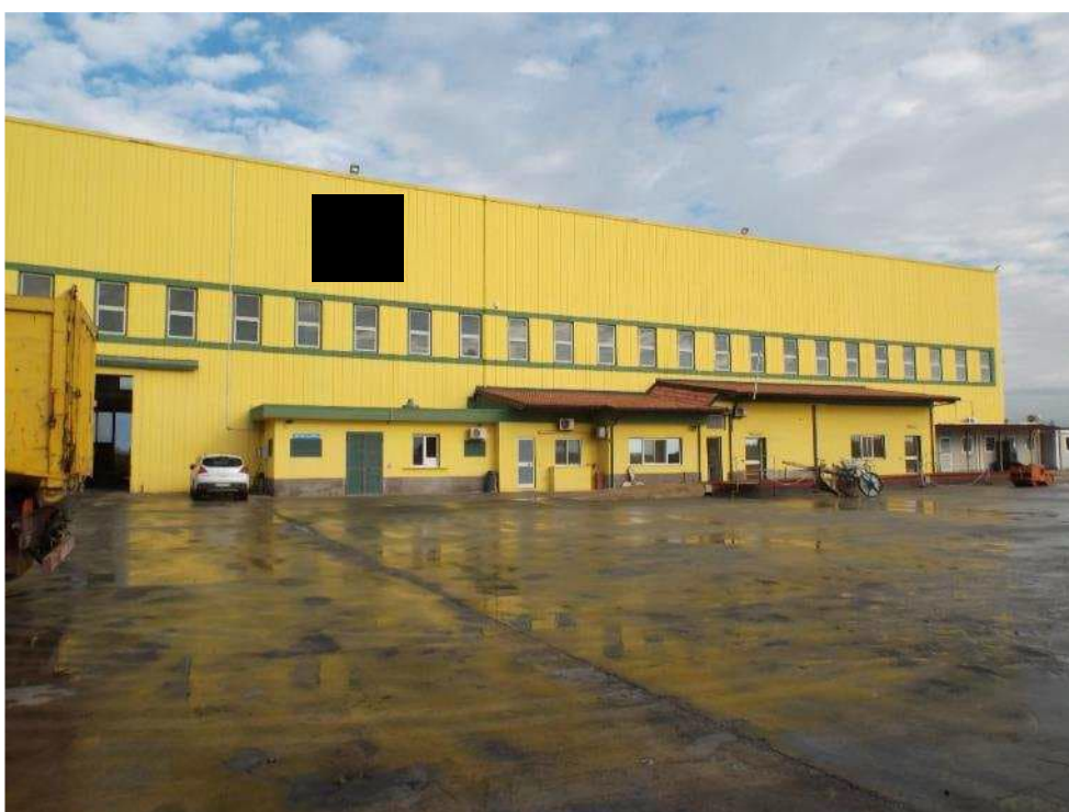
Foto n.°15- Particolare locali costruiti in adiacenza al capannone 1- Prospetto sud
