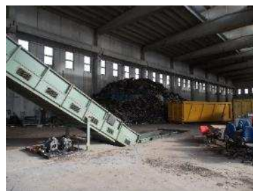
Foto n.°14 Particolare vasca
