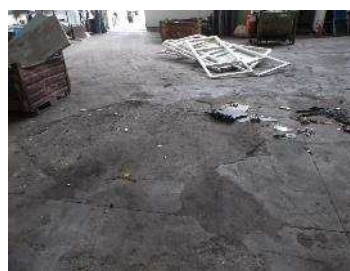
Foto 28- Pavimentazione rovinata
