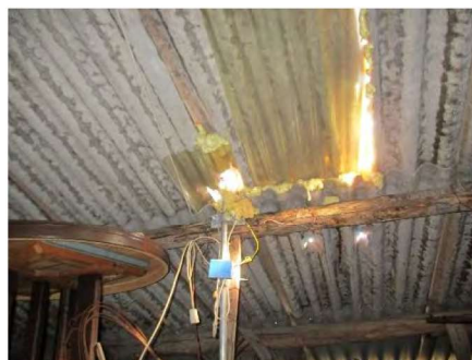
Foto n. 4- Particolare intradosso manto di copertura in eternit
