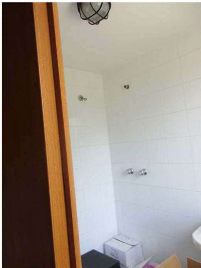
Foto 39: Scorcio del locale doccia
