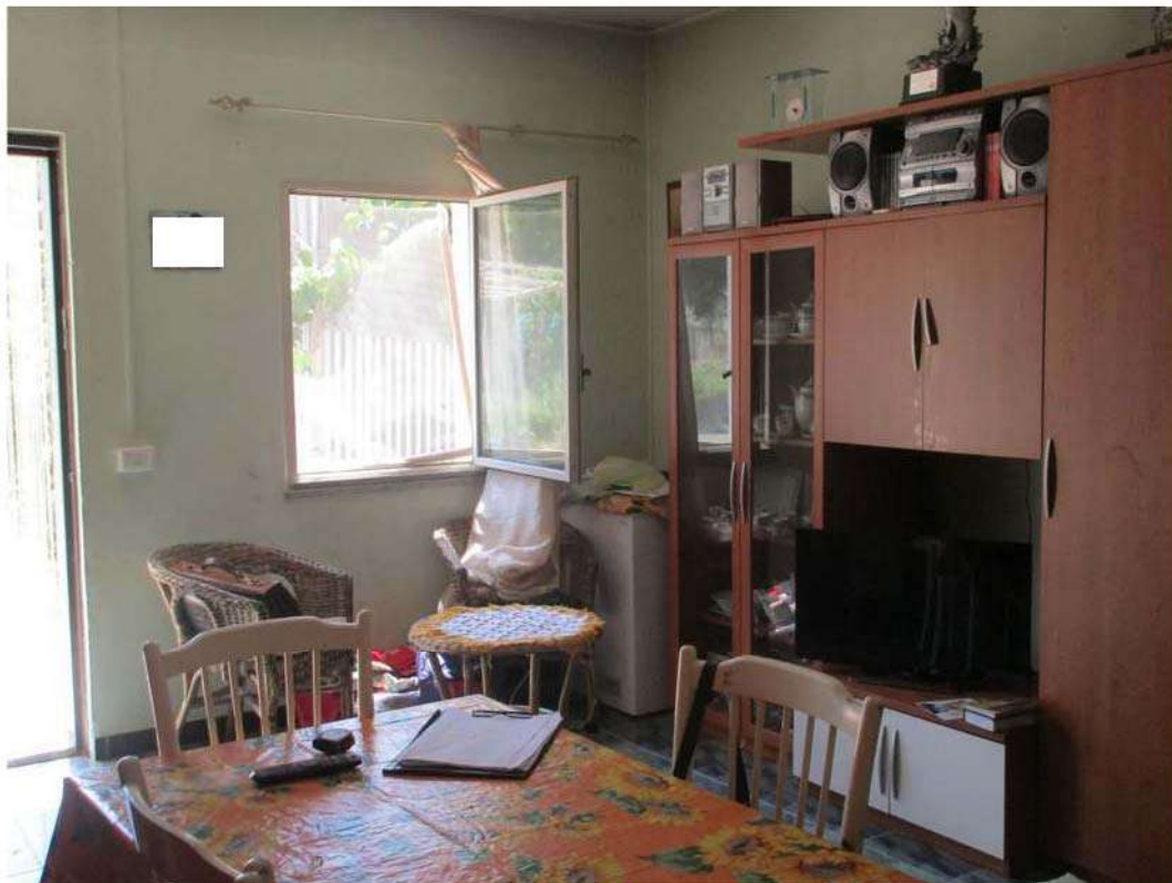
Foto 22: Scorcio delle aperture esterne realizzate in sostituzione della serranda prevista in progetto
