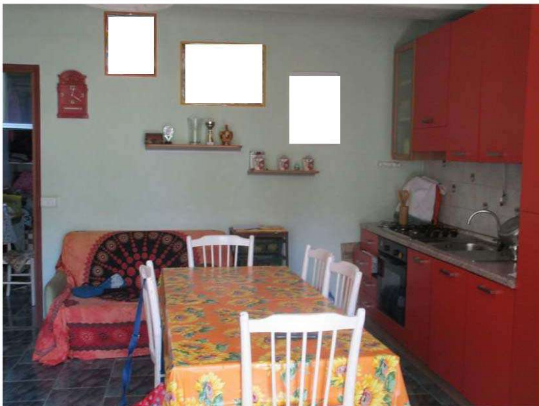
Foto 24: Sulla sinistra l'ingresso alla camera da letto privo di areazione ed illuminazione diretta
