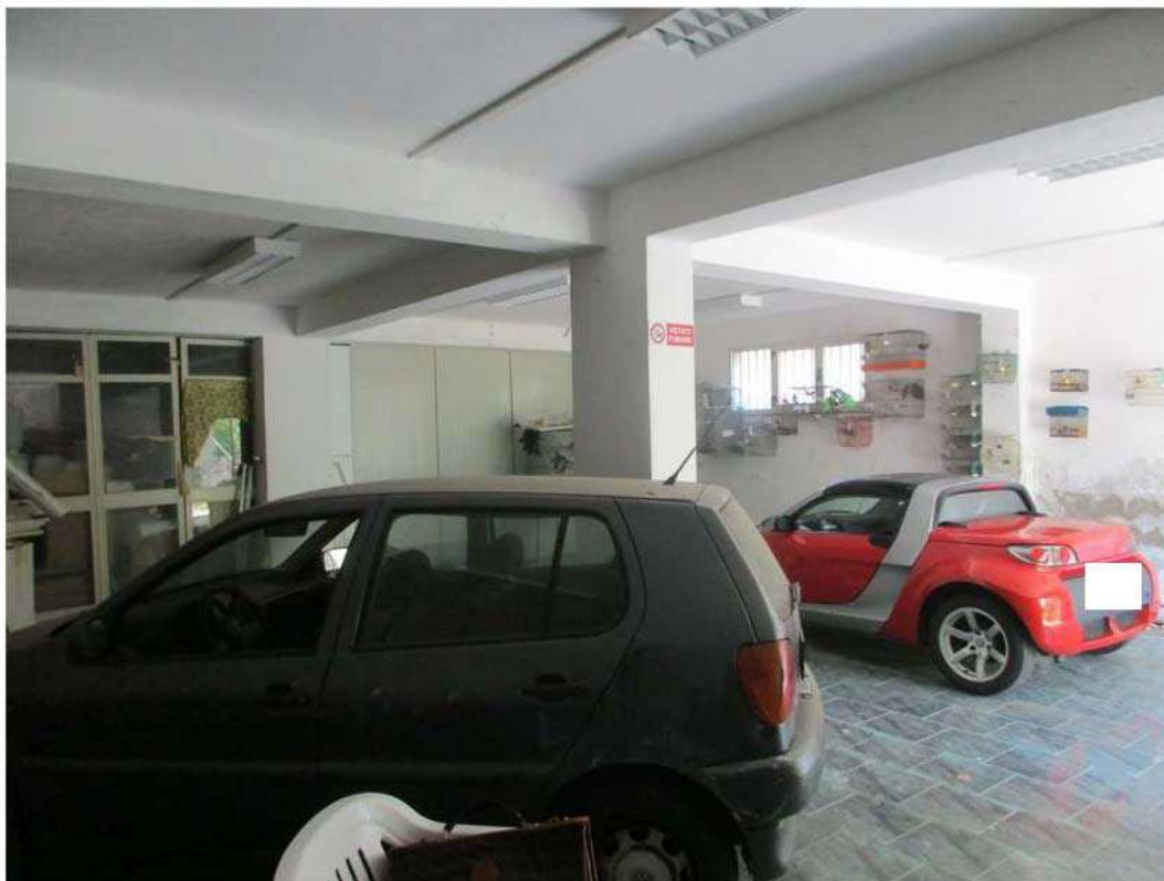
Foto 17: Porzione del seminterrato adibito a garage
