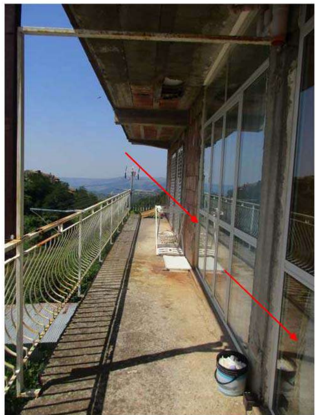
Foto 58: Il balcone sul fronte est: in evidenza le due vetrate con le quali è stata confinata l'area destinata a veranda
