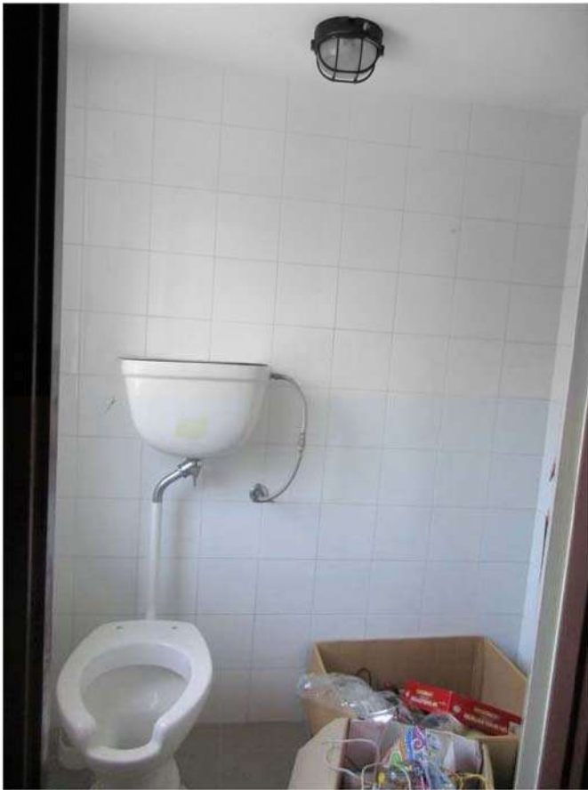
Foto 37: Vista del servizio igienico
