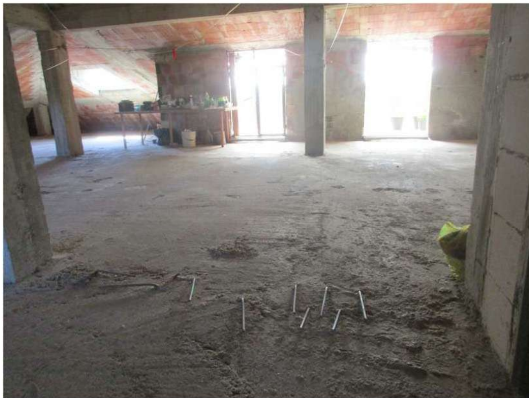
Foto 81: L'interno del sottotetto
