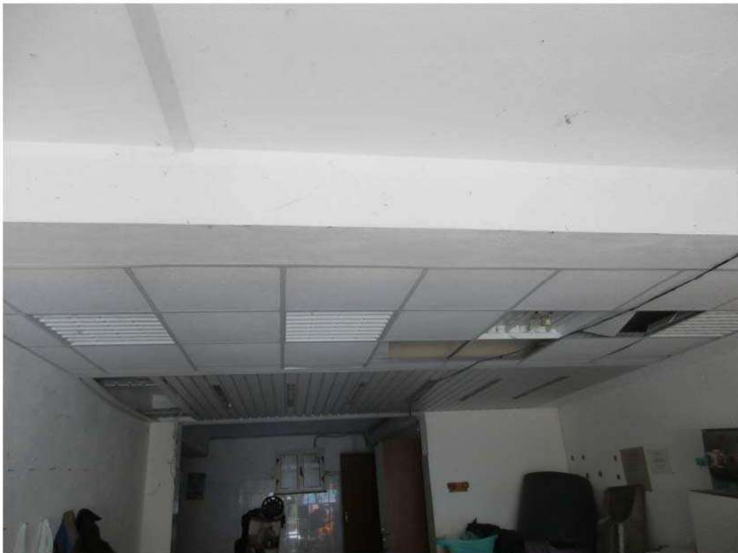
Foto 14: Particolare della controsoffittatura
