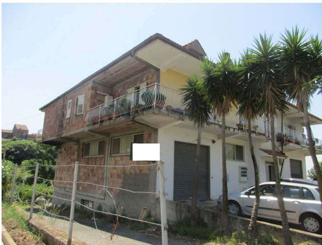
Foto 3: Vista angolo nord-ovest del fabbricato
