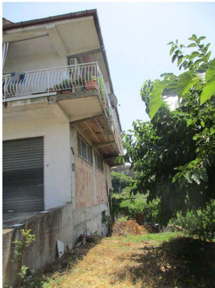
Foto 6: Il fronte Sud del fabbricato
