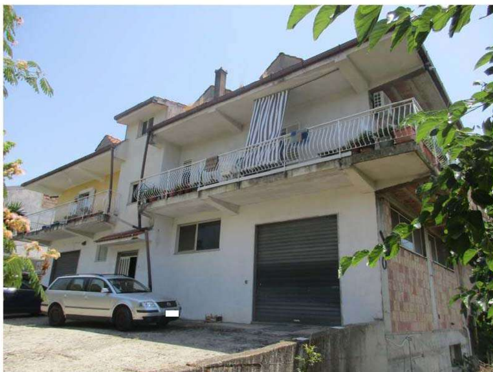
Foto 2: Vista sud ovest del fabbricato
