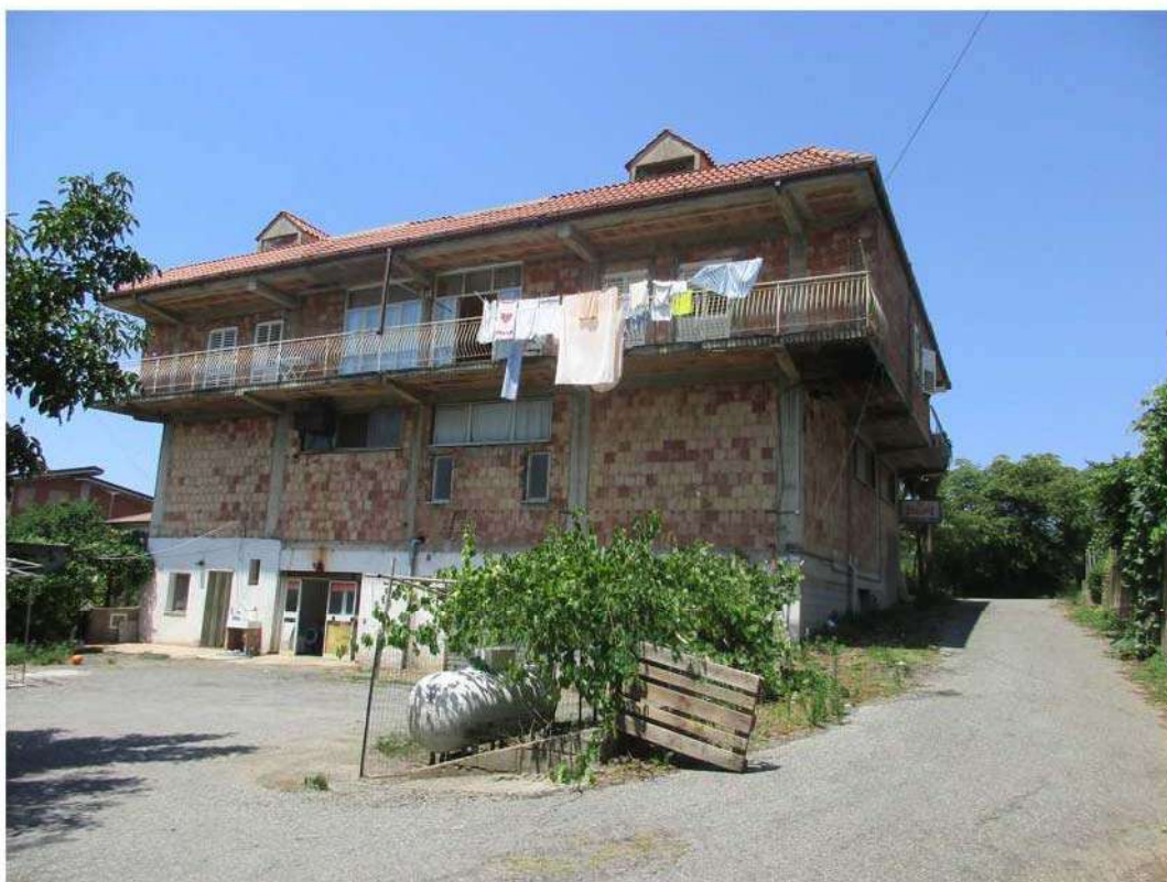
Foto 4: Prospetto est del fabbricato
