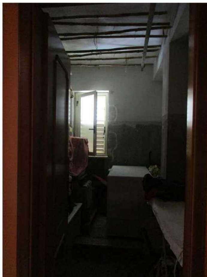
Foto 49: Il servizio igienico al rustico
