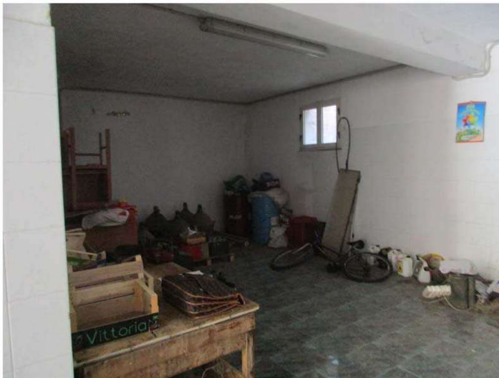
Foto 16: Vista del seminterrato da altra angolazione
