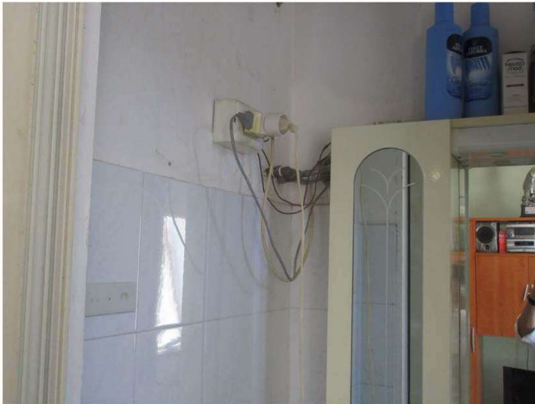
Foto 23: Scorcio del servizio igienico -
