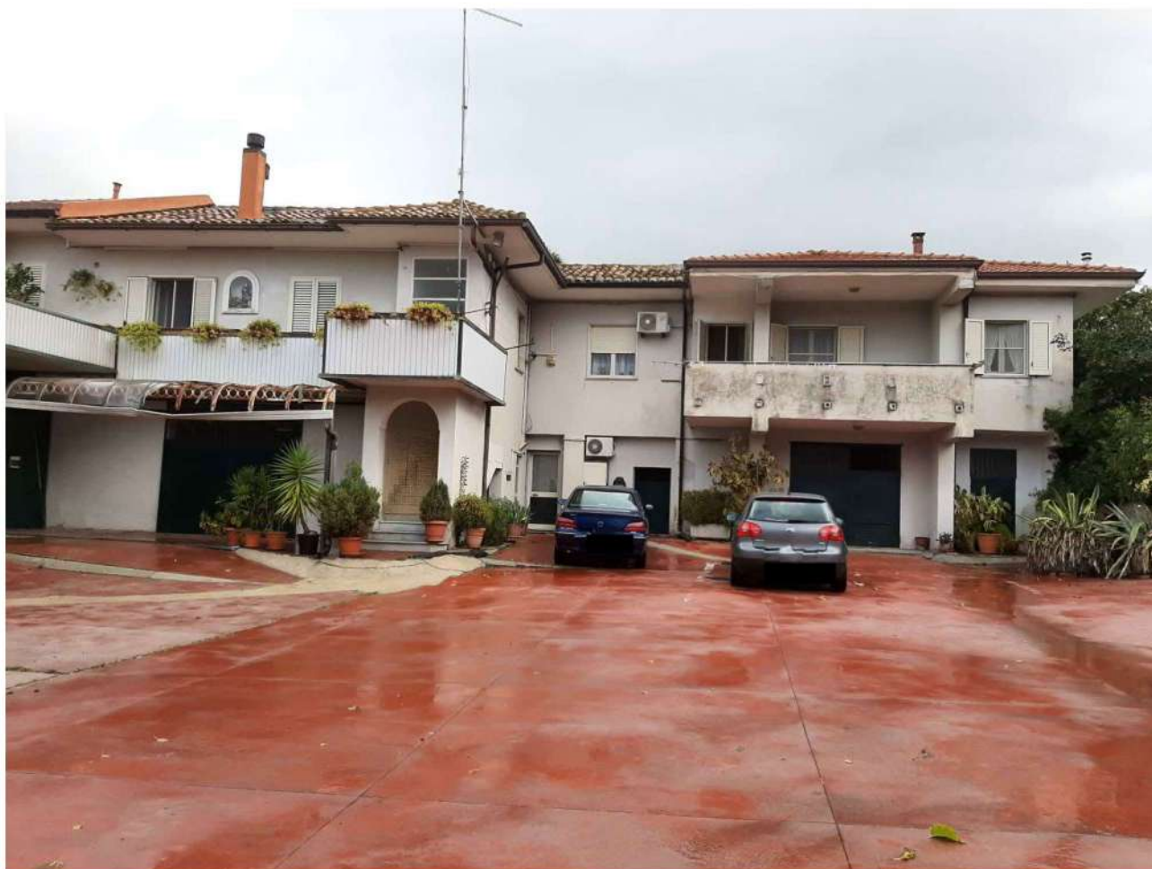
Prospetto Sud compendio
