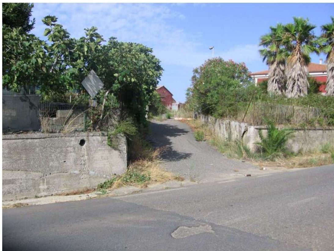
p.lla 746 – rampa accesso
