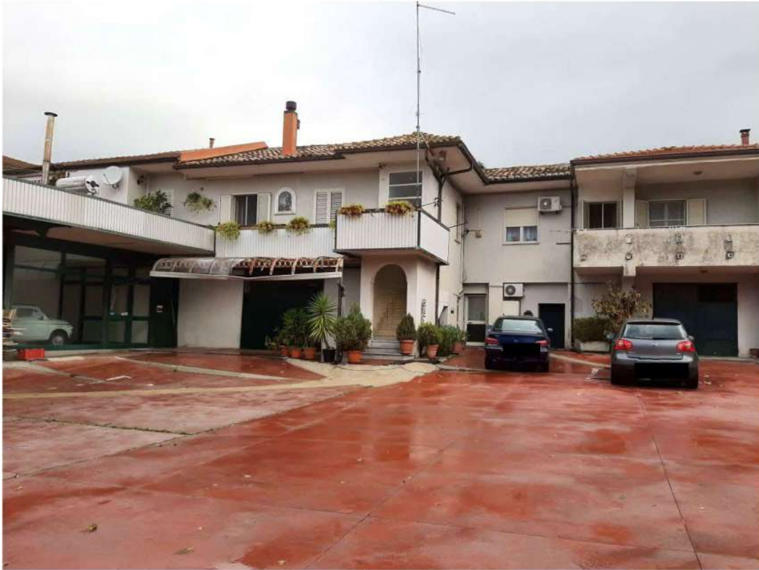
Prospetto Sud compendio
